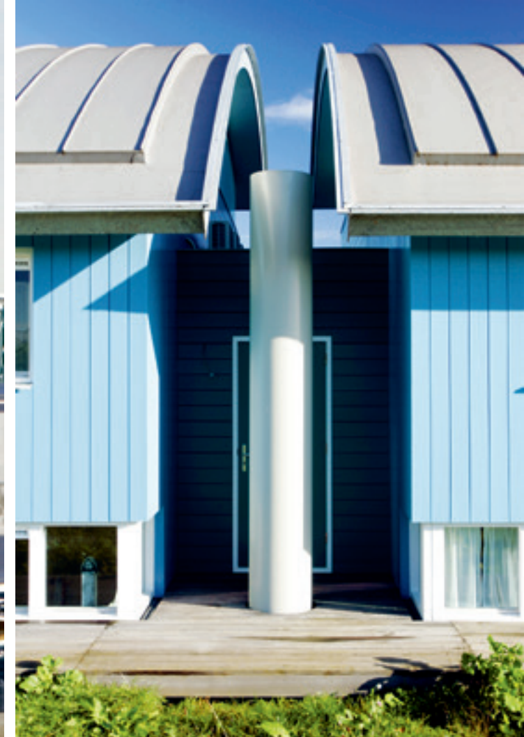
De huizen kunnen langs de meerpalen op en neer bewegen, afhankelijk van het waterniveau (foto: Dura Vermeer)
