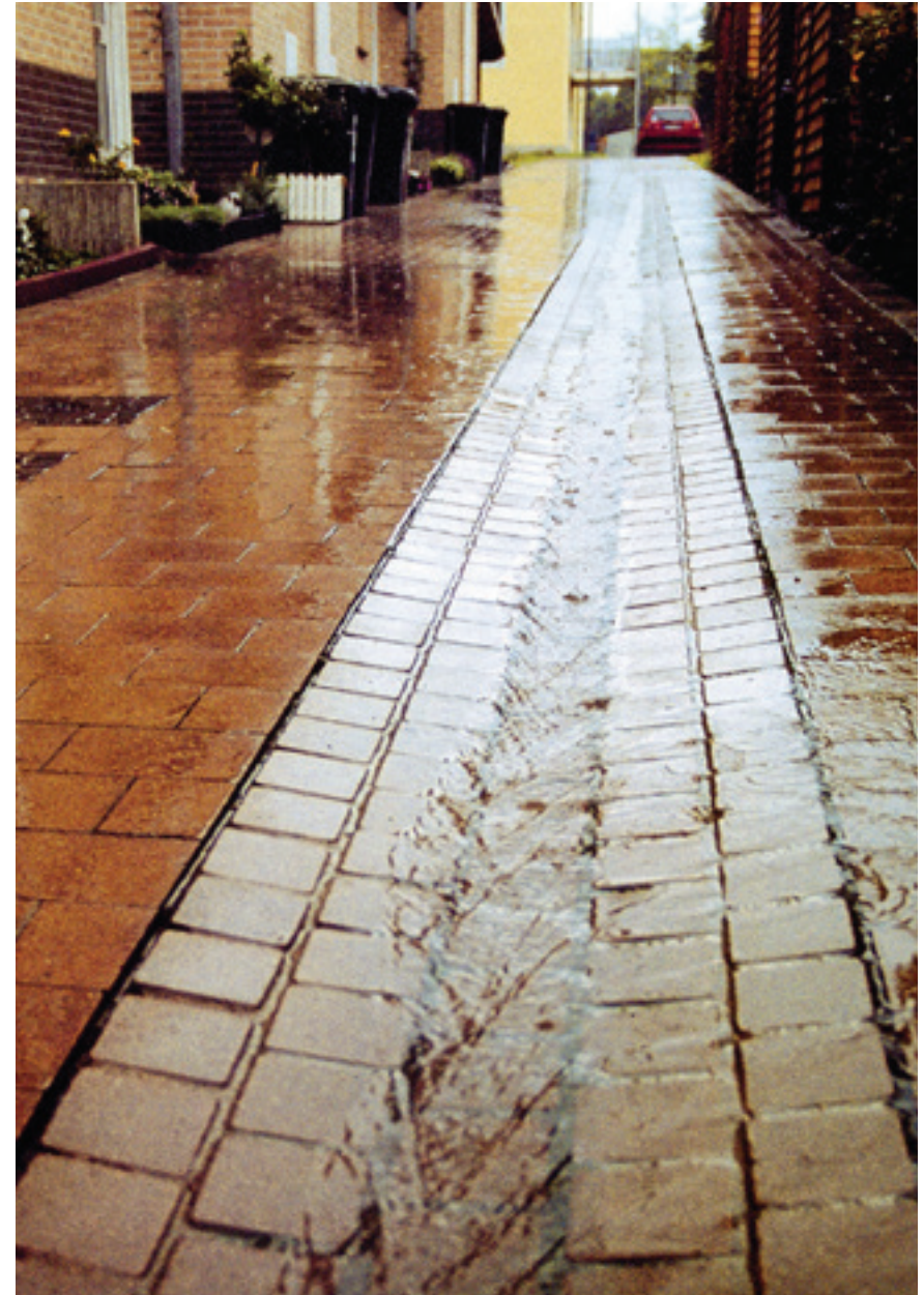
Bovengrondse hemelwaterafvoer (foto: Atelier Dreiseitl)
