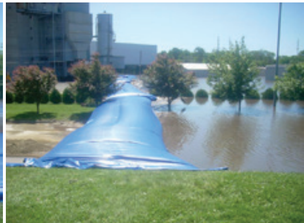
Watergepulde waterkering (foto's: hochwasserschutz-agentur.de)
