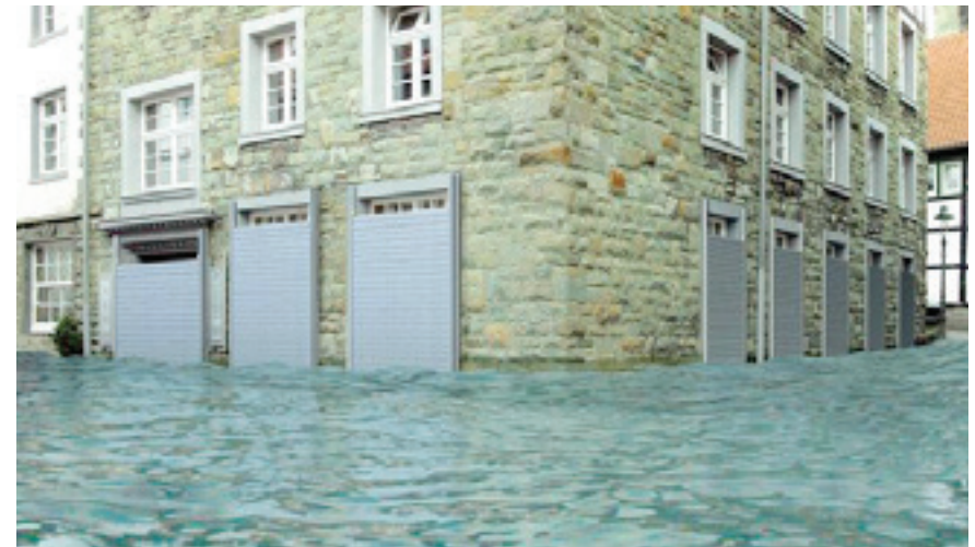
Afsluitbaar gebouw (foto: WP WASTO flood protection system)
