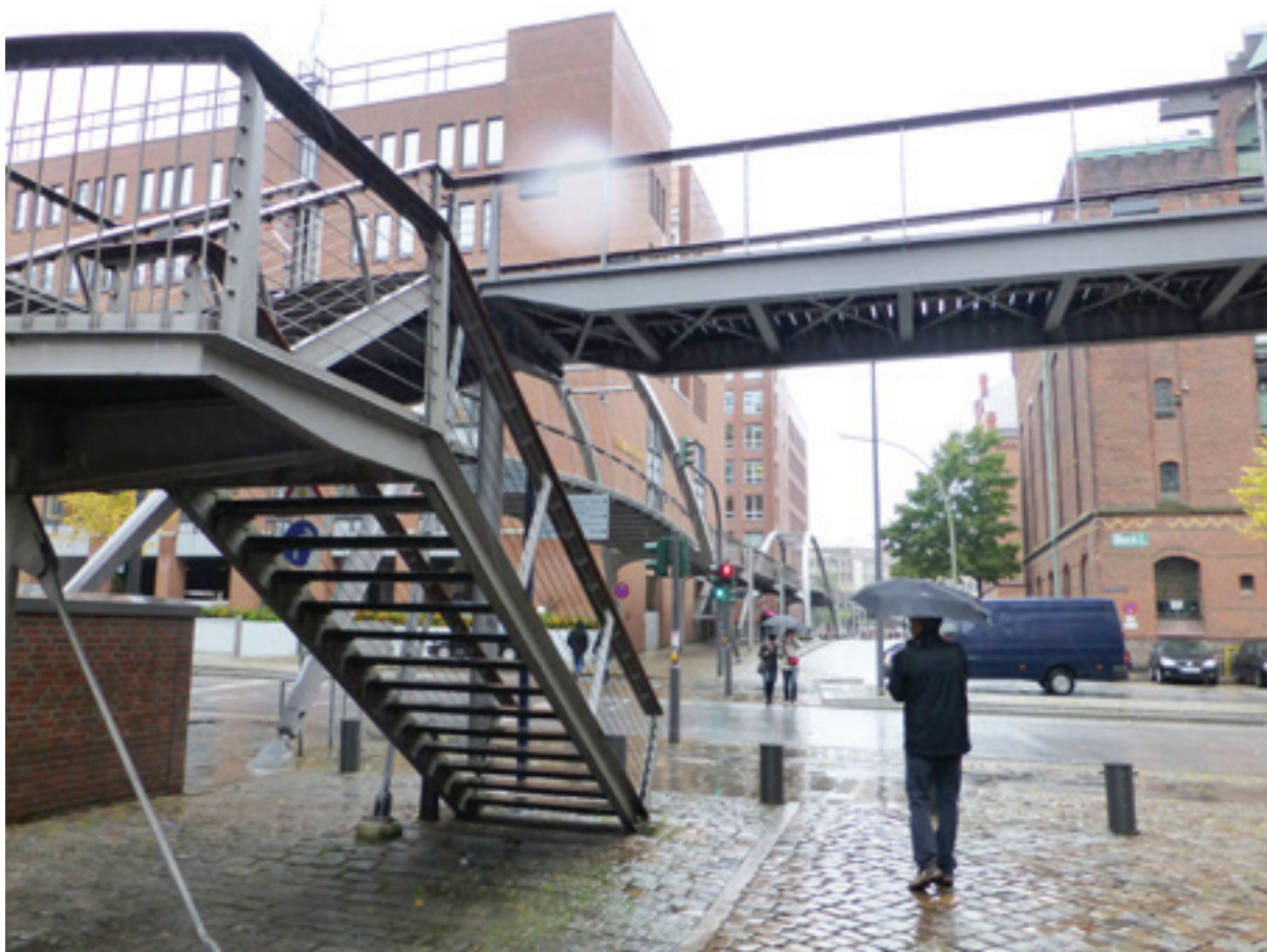
Verhoogde tweede infrastructuur voor de hoogwatersituatie (foto: Mathieu Schouten)
