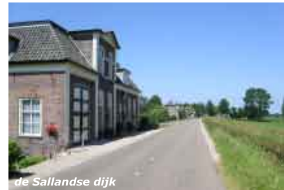
dijk in IJsseldelta bij Zalk
