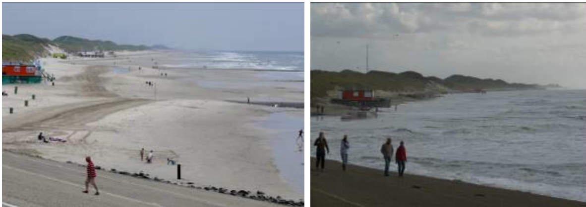
Uitzicht vanaf het zuidelijke overgang van de Hondsbossche zeewering naar de duinenkust richting Schoorl bij laagwater (links) en hoogwater (rechts)
