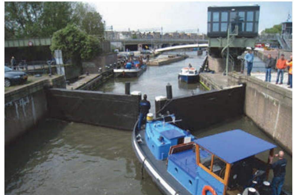
De stadskering bevat 14 sluizen. Deze moeten grotendeels handmatig worden gesloten
