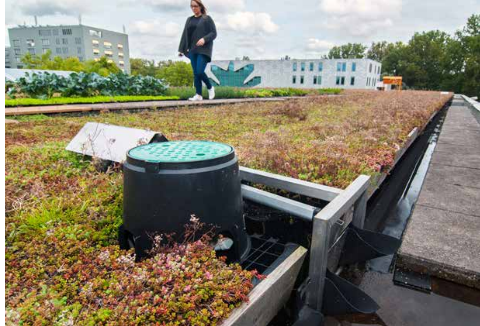
Het eerste polderdak in Nederland op Old School aan de Amsterdamse Zuidas.
