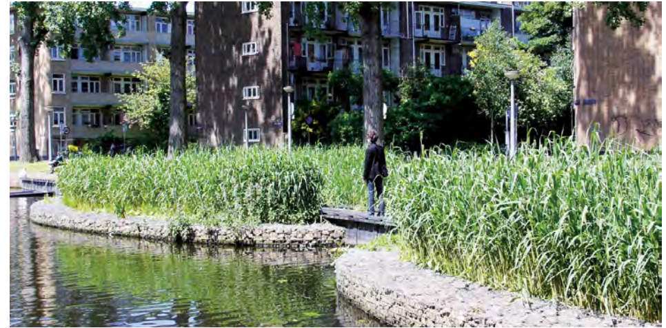
helofytenfilter Erasmusgracht voor afkoppelen en decentrale zuivering, Amsterdam
