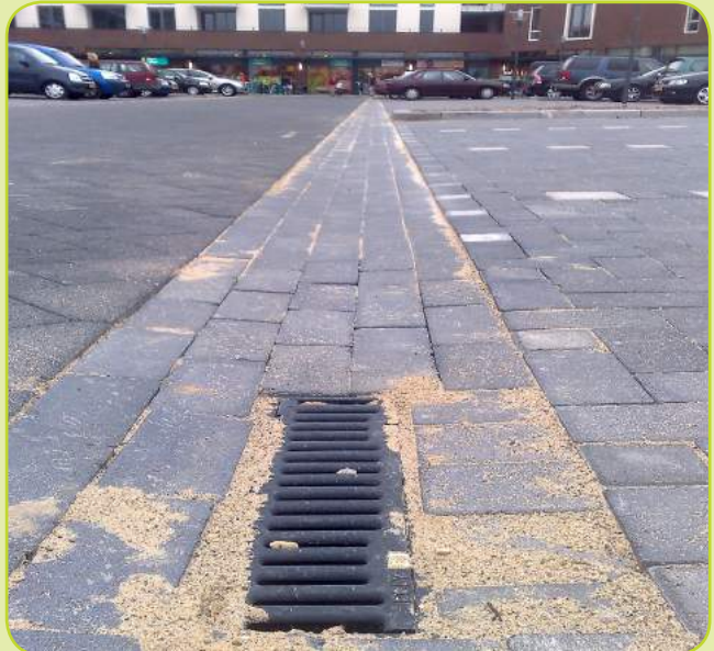
De bestrating wordt boven de drainage platen geplaatst met daarbij de benodigde afvoergoten die infiltreren in de GEP Drainage platen
