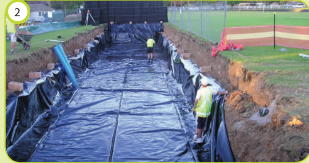
Plaats het waterdichte folie
