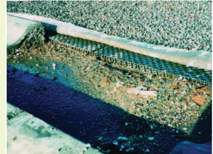
Infiltratie en buffering onder de bestrating
