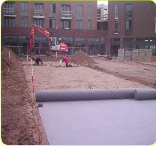
GEP Geotextiel wordt geplaatst
