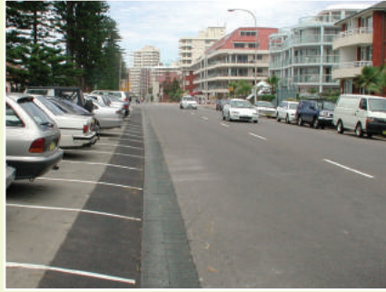
Waterdoorlatende bestrating laat het regenwater in de drainageplaten stromen.
