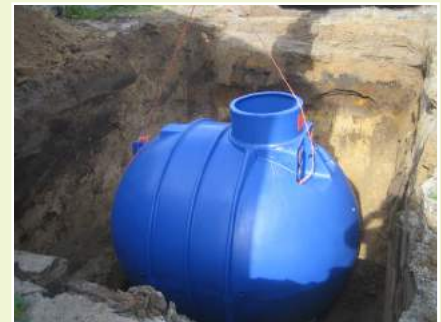
Gebruik van regenwater met kunststof tanks
