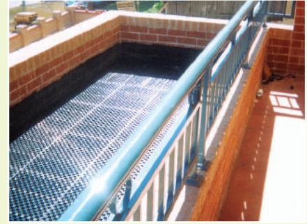
Drainageplaten vormen isolerende basis voor elke daktuin en plantenbak.
