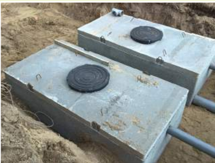
Infiltratiebakken van beton
