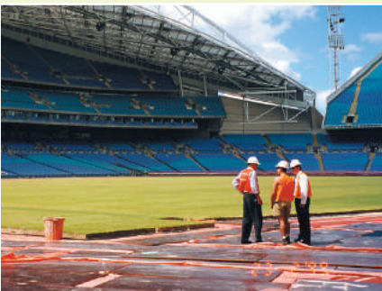
Drainageplaten houden sportvelden droog en water wordt gerecycled.
