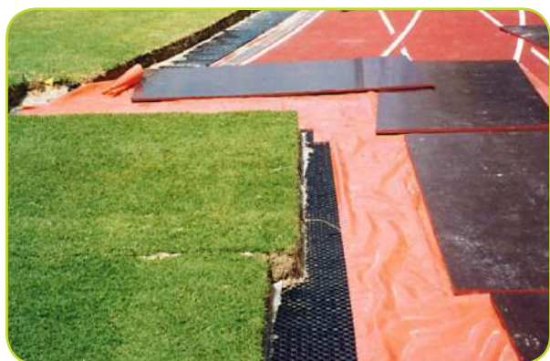
1 Plaats drainageplaten op folie
