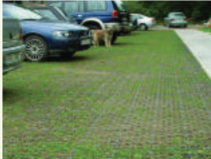
Waterdoorlatende parkeerplaatsen met grastegels
