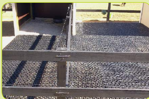
1 Plaats drainageplaten in dressuurbak
