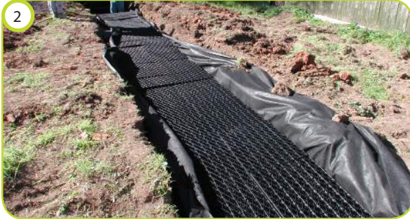
Vouw het geotextiel terug
