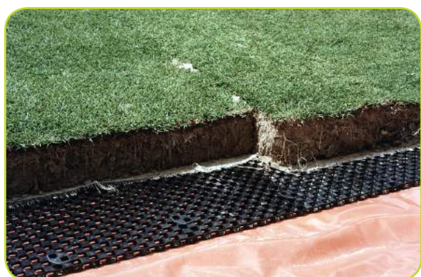
2 Leg het geotextiel en graszoden op de drainageplaten
