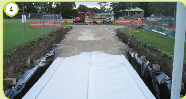
Plaats geotextiel en vul aan met zand
