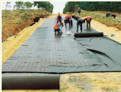
Horizontale drainageplaten voorzien in buffering en infiltratie onder de bestrating.
