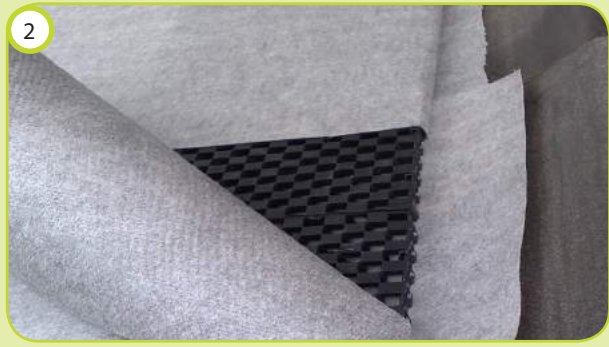
2 Plaats geotextiel
