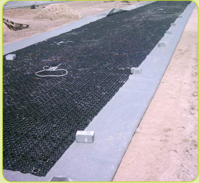
De GEP 52 mm Drainage platen worden op het Geotextiel gelegd
