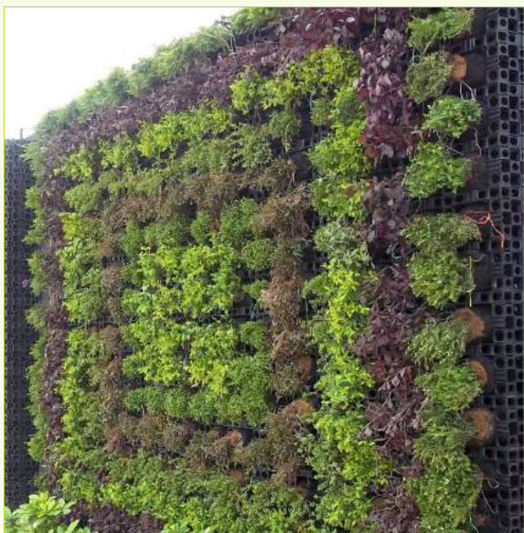
Groene muur met GEP Gro-Wall Pro
