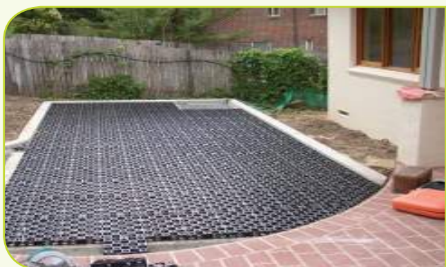
1 Waterdoorlatende "besstrating" met gras tegels
