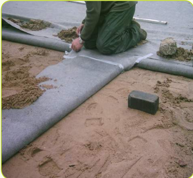
De GEP 52 mm Drainage platen worden omwikkeld in Geotextiel
