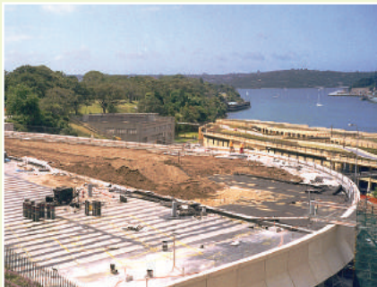
Drainageplaten maken grote daktuinen, zelfs met zware belasting, mogelijk.
