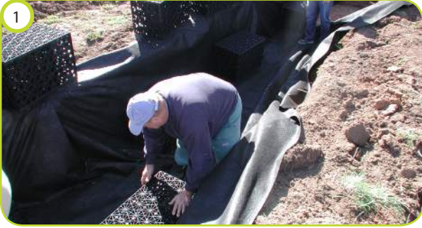
Plaats de boxen in het geotextiel
