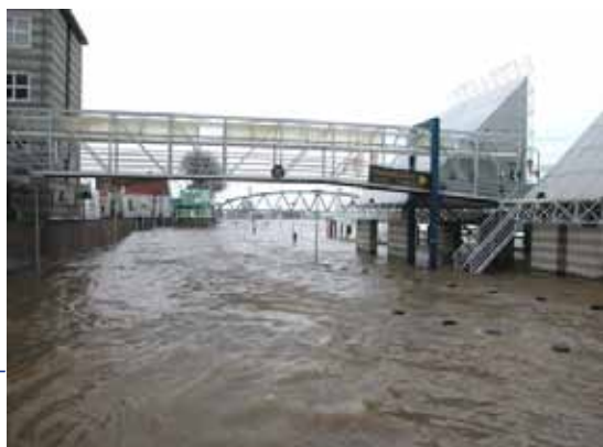
schadebeeld Nijmegen: Waalkade overstroomd in 2007
