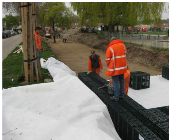
● Infiltratiekratten onder verharding
