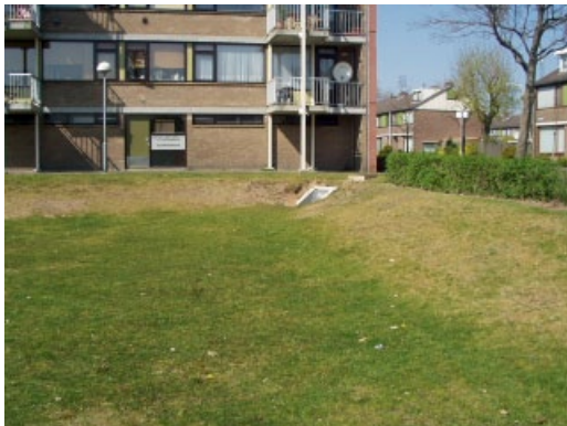
Figuur 6.8 Uitstroom bij flatgebouw.
