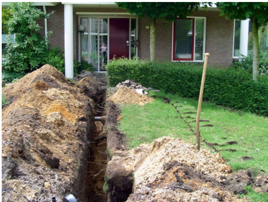
Figuur 8.2 Afkoppelen regenwater van een woning.
