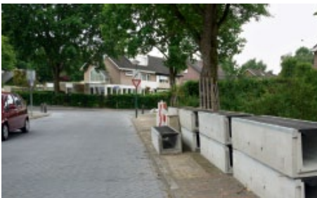
Figuur 2.11 Aanleg roostergoten.
