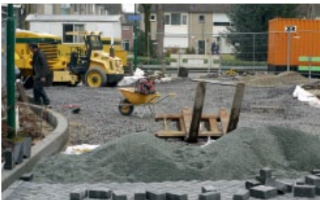
Figuur 2.9 Aanleg doorlatende en bergende verharding (Aquaflow).
