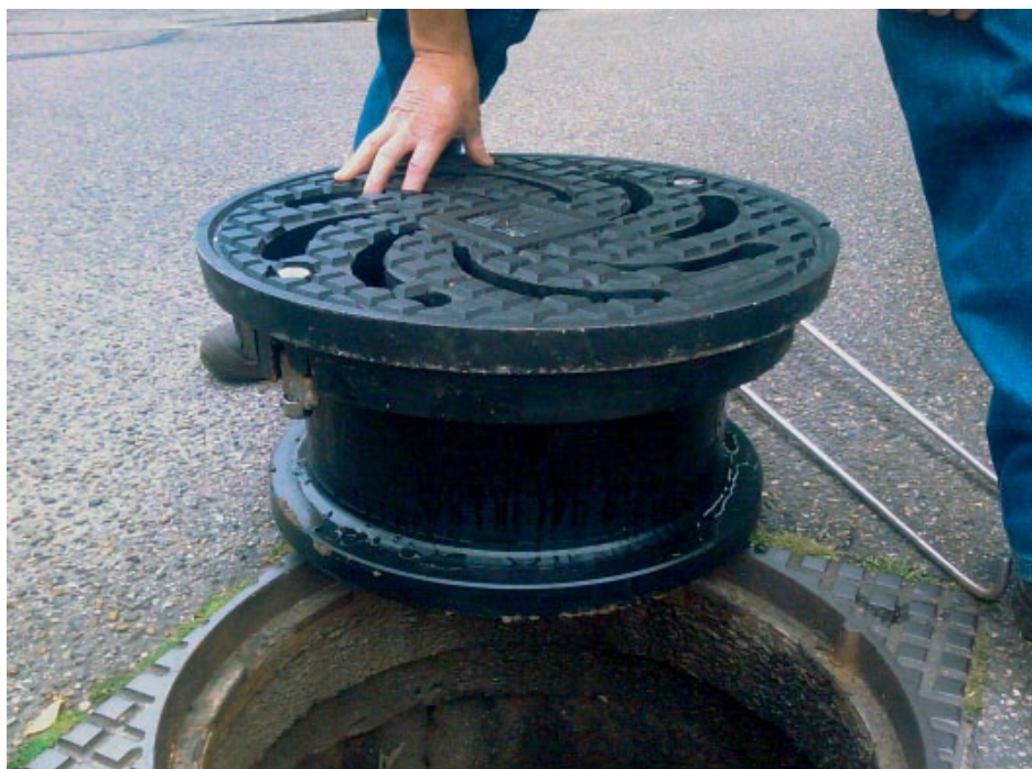
Figuur 17.20 Plaatsing van een ontluichtingsputdeksel (Bron: TBS)
