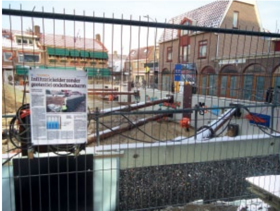
Figuur 4.4 Aanleg infiltratiebassins in het centrum.
