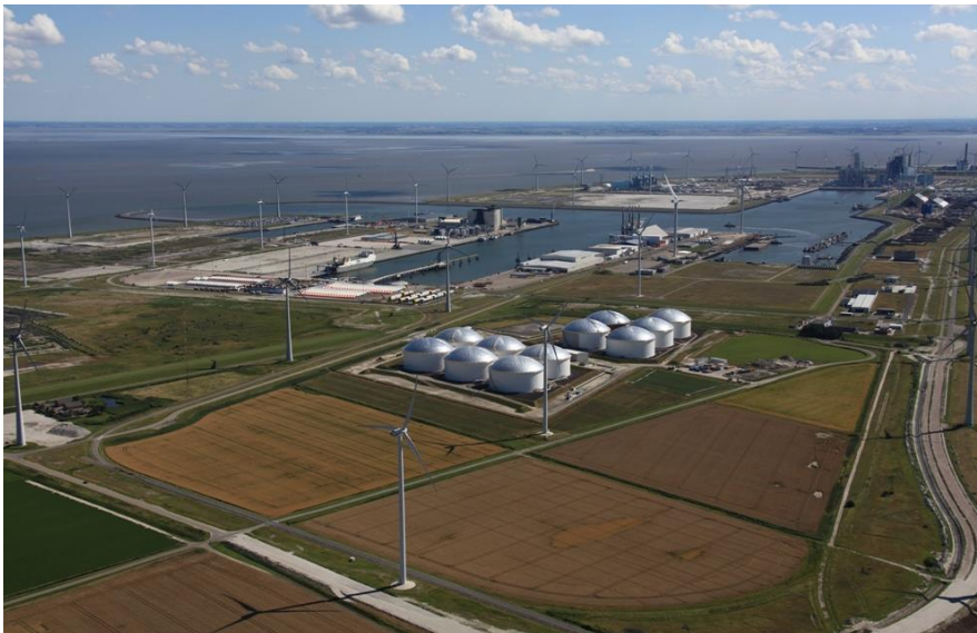
Figuur 4.10 Locatie Eemshaven met op de achtergrond de in aanbouw zijnde centrales
