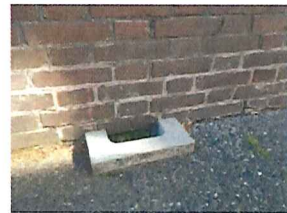
verhoogde instroom m.b.v. betonnen rand
