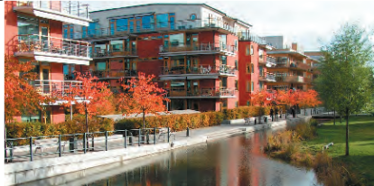
Schieboulevard als waterkering
