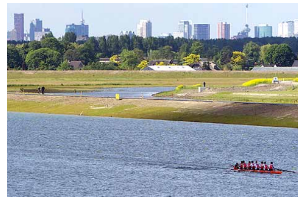
Waterberging middels aanleg van de Willem Alexander roeibaan
