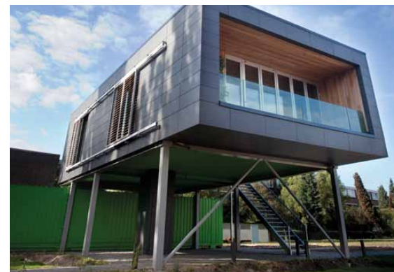
Concept House Village Heijplaat: floodproof bouwen
