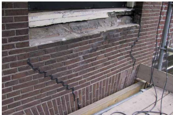
Verzakkingen als gevolg van droogte
