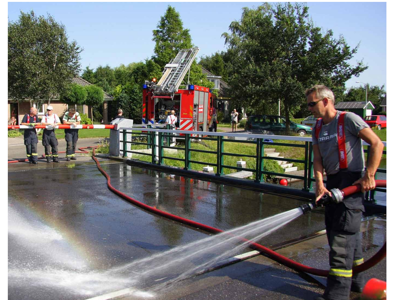
Nat houden brug om te voorkomen dat deze door uitzetting niet meer functioneert
