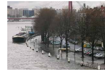
Overstroming kade Noordereiland
