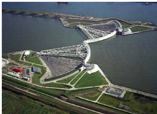
Maeslantkering in de Nieuwe Waterweg
