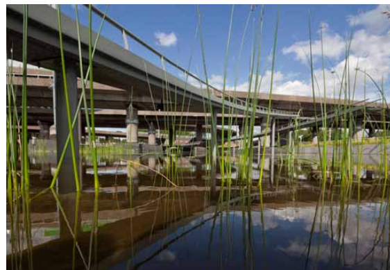
Tijdelijke waterberging onder het Kleinpolderplein
