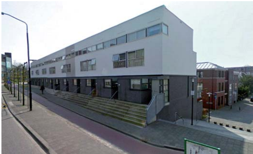
Geïntegreerde kering in bebouwing (bron: Google Street view)
