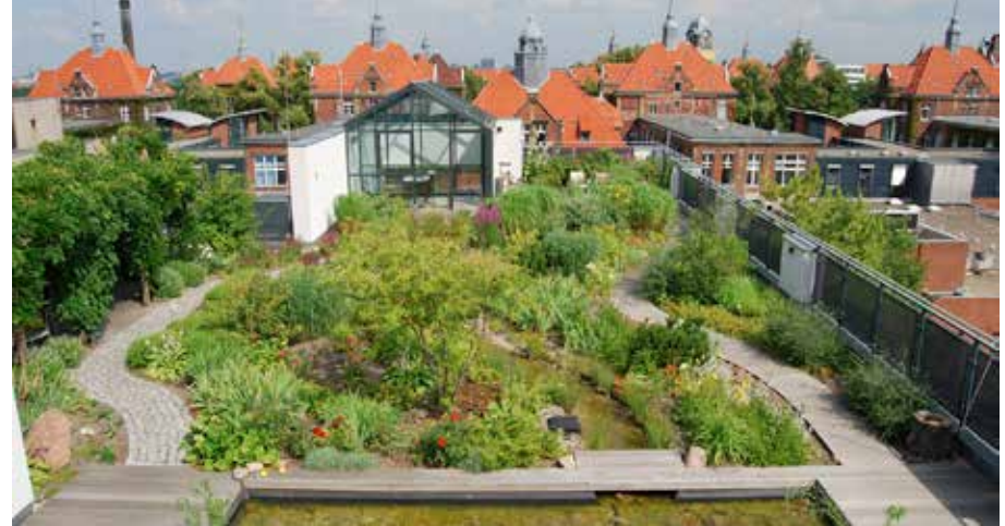
Intensief groen dak- verblijfsdak, foto van Optigroen
