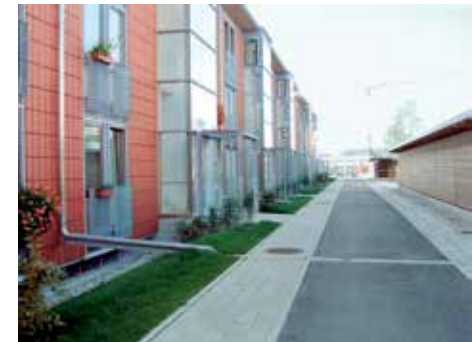
Voorbeeld bovengrondse regenwaterafvoer: molgoot, Solar City, Linz bron: Atelier Dreiseitl
