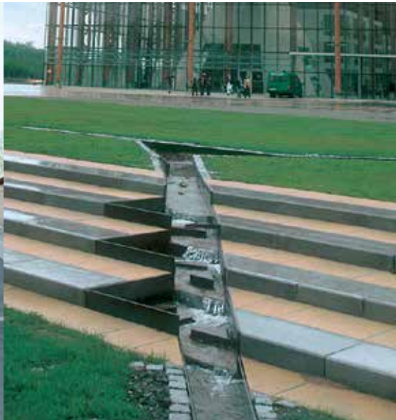
Open goot Mont-Cenis, Atelier Dreiseitl
