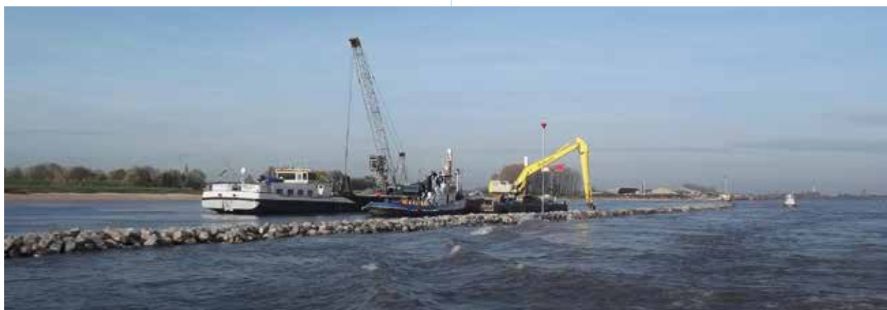
Fig. 3.5: Langsdammen vervangen kribben
