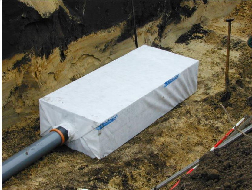
Figuur 15. Een infiltratiekrat wordt in de grond aangebracht (Beuker, sd)
