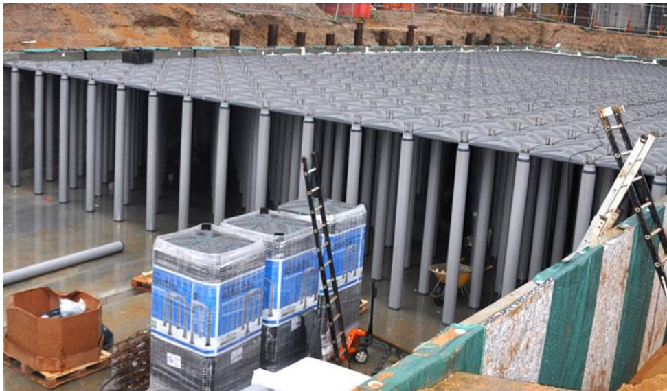
Figuur 24. De watershells in aanbouw (Grond/weg/waterbouw, sd)
