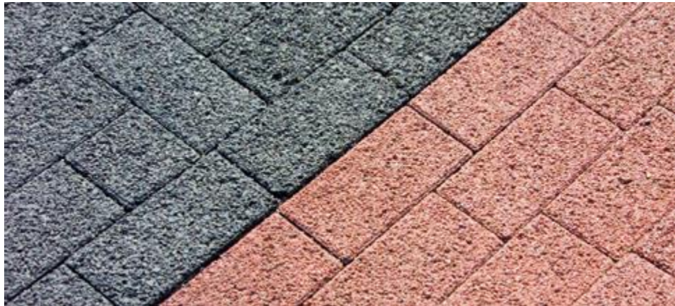
Figuur 4. Waterdoorlatende verharding (Febestral, 2008)
