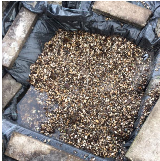
Figuur 16. De grindkoffer (Klusidee, sd)
