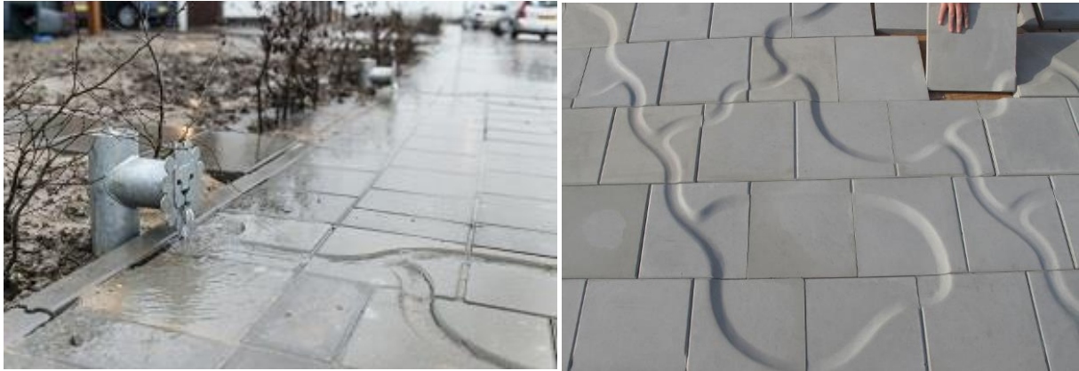
Figuur 32 Watertegels met speciale exfiltratiekolk (Struyk Verwo, 2015)
