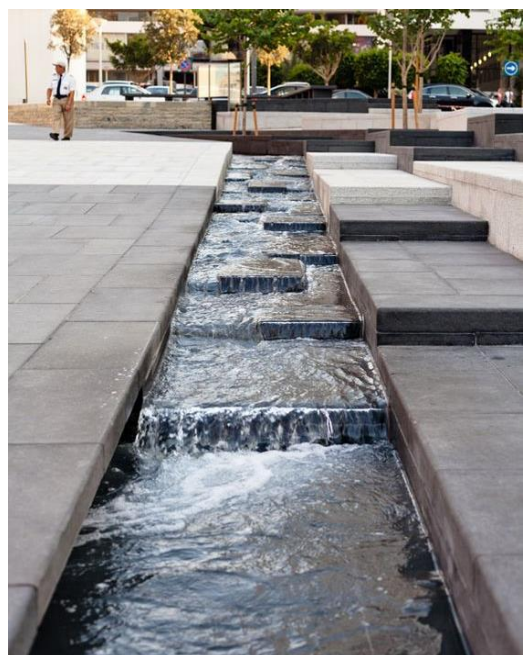
Figuur 36: Gecontroleerde afstroming in publieke ruimte (Torta)
