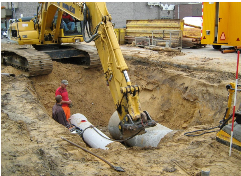
Voorbeeld riolvervanging en afkoppelen
