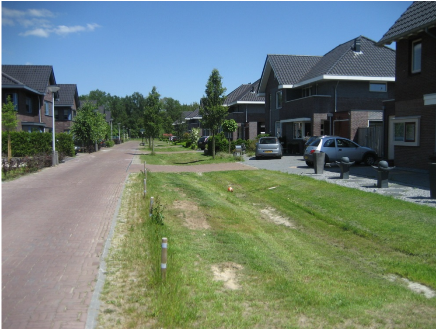
Afvoer van hemelwater via een wadi
