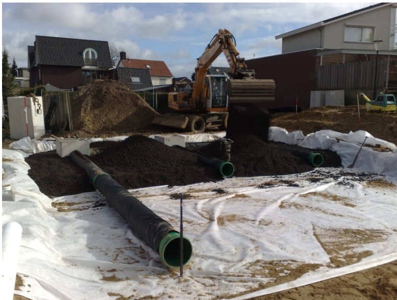
Aanleg infiltratiesysteem
