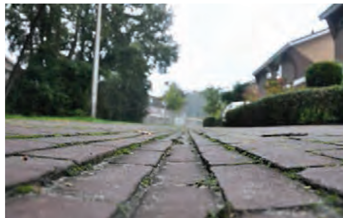
Een goot op straat in Enschede om het regenwater af te voeren.
