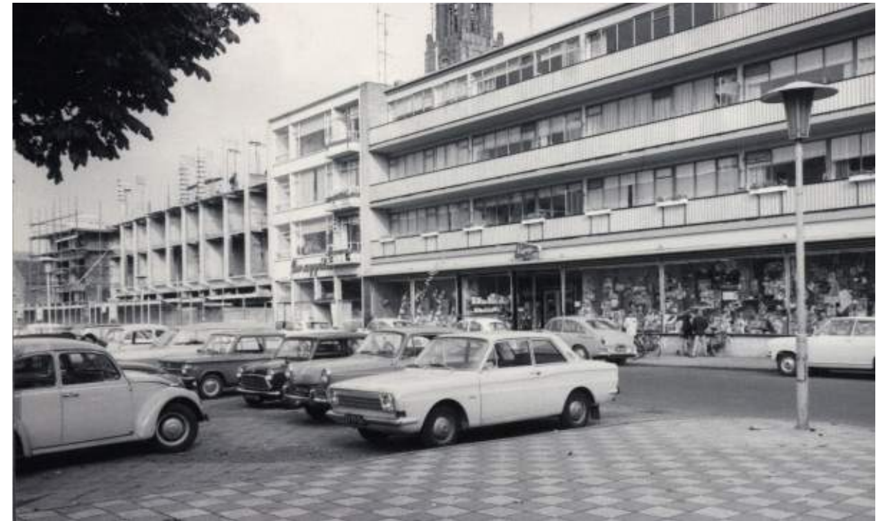
fig. 27 slechts één onderdeel van het plan Froger werd daadwerkelijk uitgevoerd: de Nieuwe Markt, een modern stadsplein, bestemd voor winkels en kantoren. Foto omstreeks 1968. [Erfgoedhuis Weert]
