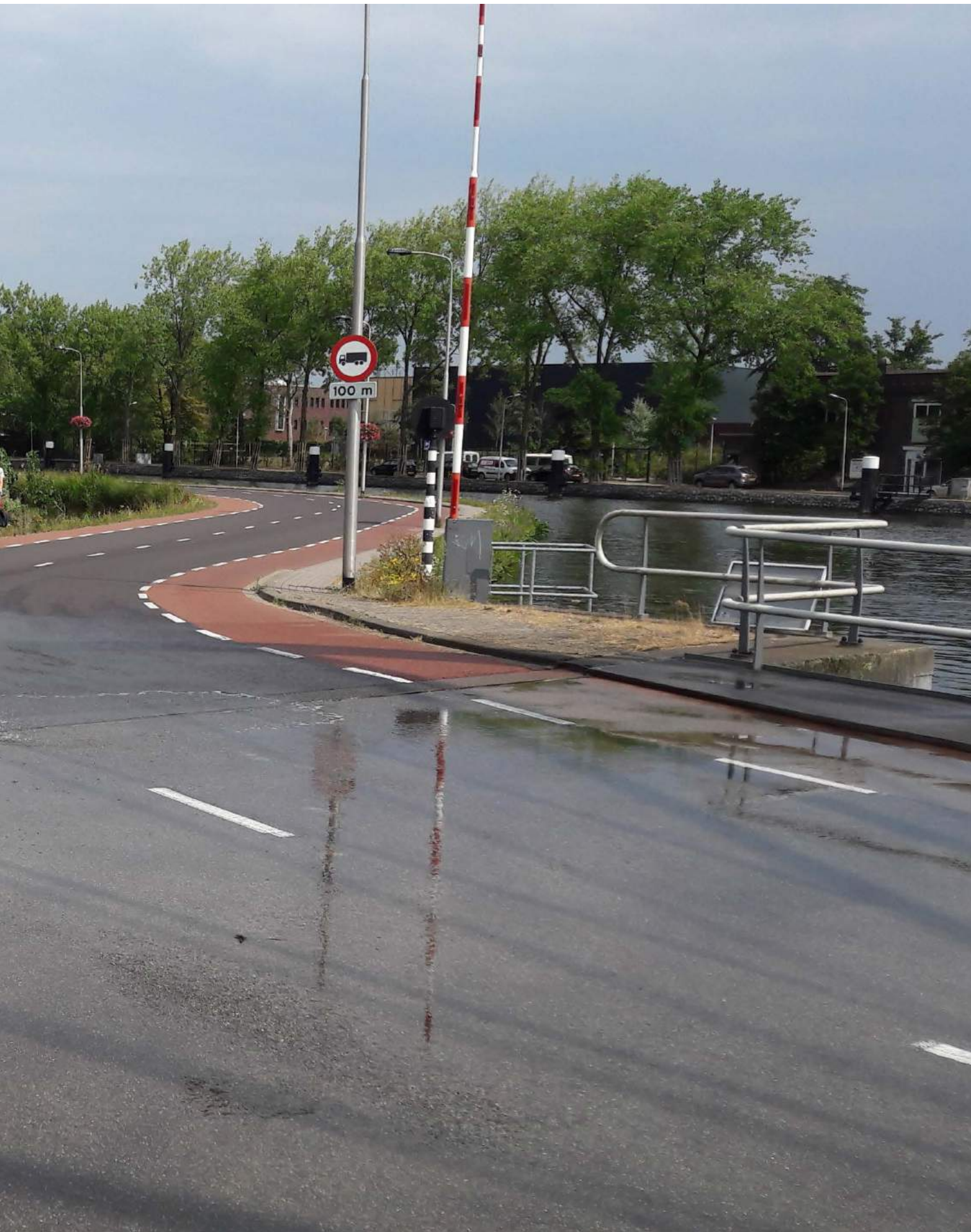
Koelen van de Koolhavenbrug om uitzetting door hitte te voorkomen, 25 juli 2018 - Bron: Gemeente Delft
