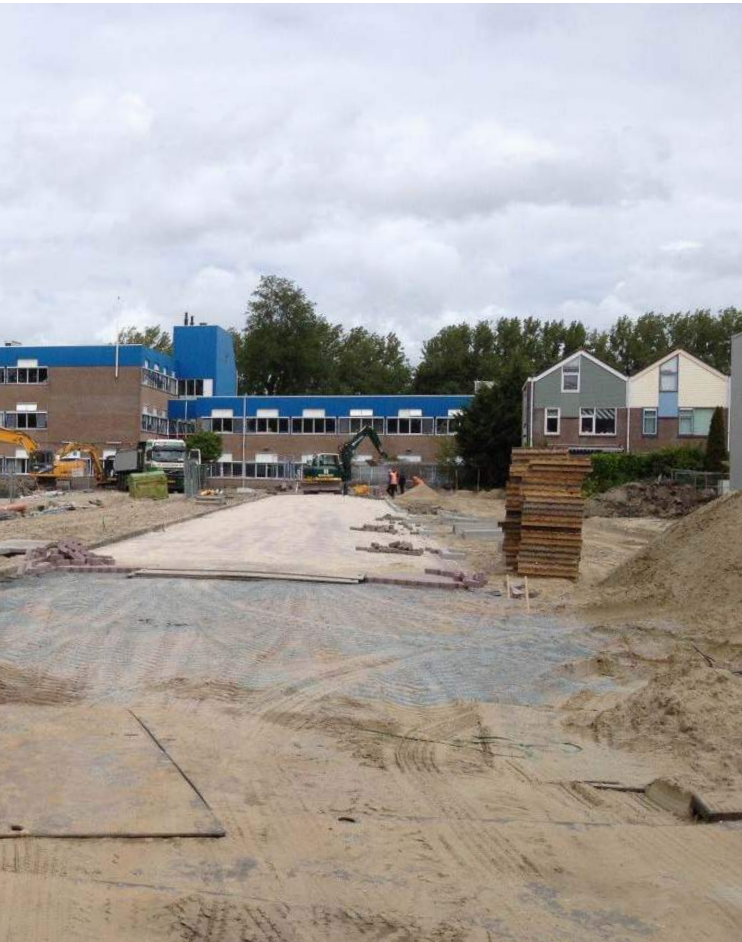
Impressie van de aanleg van waterberging in de straat Lodenvloer. Water wordt opgevangen in holle ruimten onder de weg, bron: Gemeente Delft
