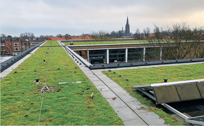
Sedumdaken na aanleg. (Foto: Universal Greenfields)
