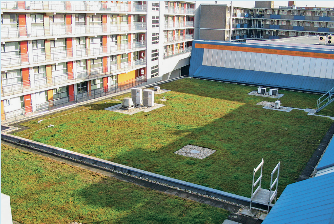
Groen dak 700 m 2 .
