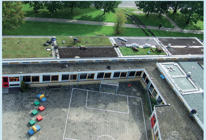
Dak van bovenaf. (Foto: Michiel Rijdsijk)
