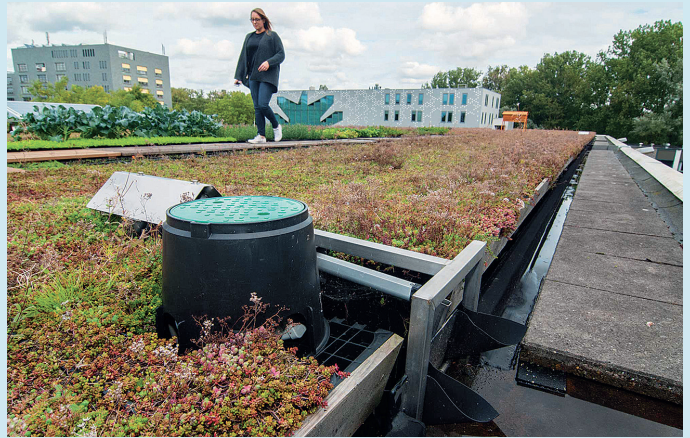
Klepsturing op groen sedum dak met groente- en kruidentuin van het in het gebouw gevestigde restaurant. (Foto: Dakdokters)
