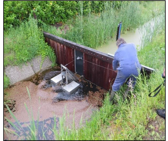
Figure 10, Adjustable Weir, Retrieved From: https://www.stowa.nl/publicaties/zelfvoorzienendheid-zoetwater-zoek-de-mogelijkheden
