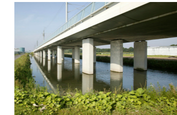
Spoorviaduct HSL, Bleiswijk.
