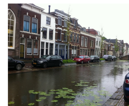
GOUDA Wateroverlast en scheve woningen door bodemdaling. De historische binnenstad van Gouda gemiddelt 3 mm per jaar. Foto: Jacques van Alphen.
