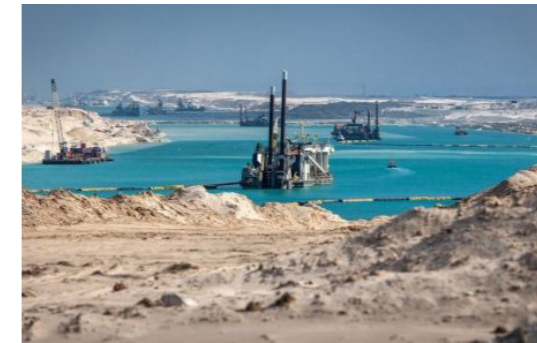
Voorbeeld SUEZKANAAL In 2014 bereikte twee Nederlandse baggerbedrijven een dagrecord met 1,4 miljoen kuub zand suppletie. Hiervoor werden 23 snijkopzuigers en 4 sleephopzuigers gebruikt.
