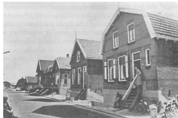
Met versterking van de dijken na de watersnoodramp van '53, werden in Krimpen a/d Lek 30 panden opgevijzeld.
