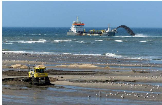
HOLLANDSE KUST Jaarlijks wordt de kust met 12 mln m3 zand versterkt. Bij niks doen verplaatst de kustlijn zich ieder jaar 1 m landinwaarts.
