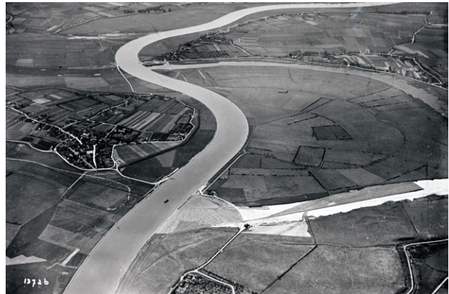
Om de afvoer van de Maas te verbeteren en zo het overstromingsgevaar te verminderen voerde Rijkswaterstaat in de jaren 1930 onder meer bochtafsnijdingen uit, zoals hier bij Maasbommel-Megen. © https://beeldbank.rws.nl , Rijkswaterstaat
