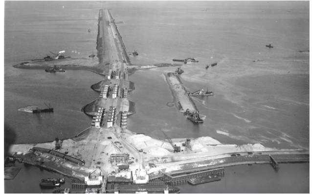
KLM maakte luchtfoto's van de Afsluitdijk (1932) © https://beeldbank.rws.nl , Rijkswaterstaat
