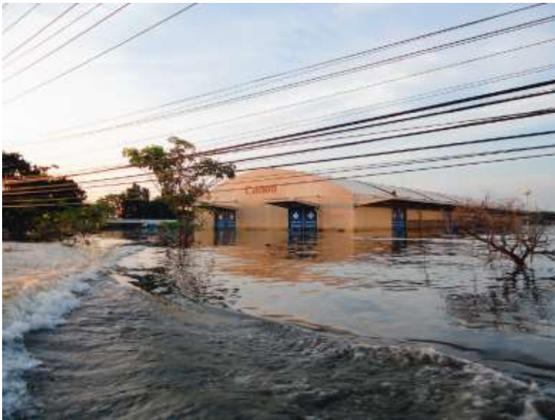
Figuur 9. Overstroming van een industriecomplex nabij Bangkok in Thailand in 2011. Een geval van het overschrijden van de grenstoestand "bezwijken", omdat allerlei apparatuur in fabrieken zoals deze op de foto verloren is gegaan en de productie maanden stil heeft gelegen als gevolg van het opruimen en aanschaf/installatie van nieuwe apparatuur.
