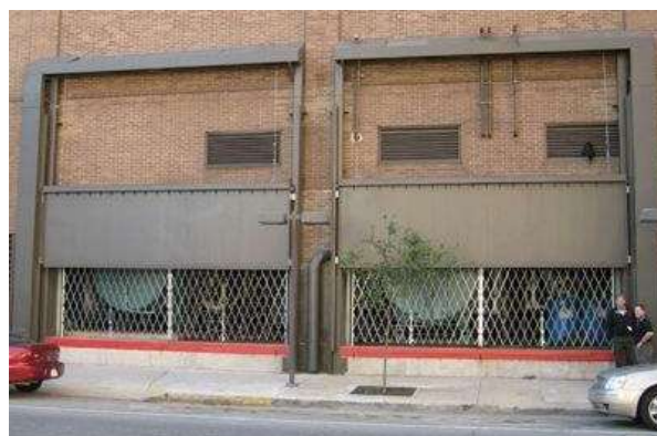
Foto: Voorbeelden van 'Dry proofing' met panelen om het gebouw waterdicht te maken (links) en waterdichte deuren die gesloten kunnen worden (rechts).
