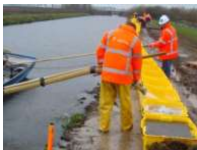
Figuur 27. Voorbeelden van noodkeringen: Box Barrier (links), systeem gevuld met lucht (midden) en vrijstaand keermiddel (rechts).
