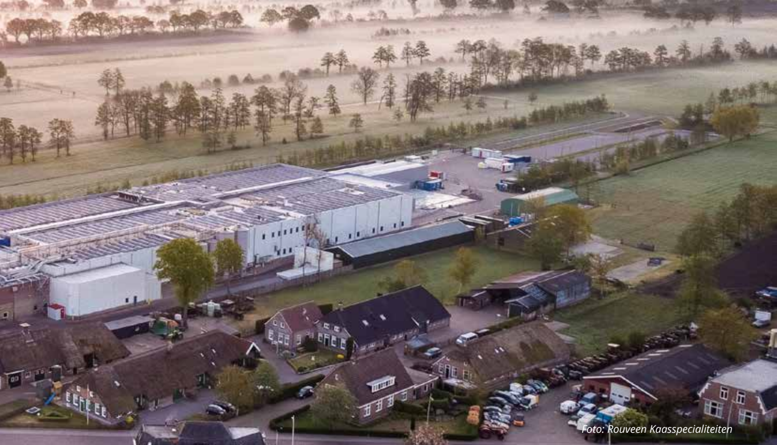
Op het dak van de fabriek liggen 2.360 zonnepanelen die circa 545.000 kWh stroom opleveren
