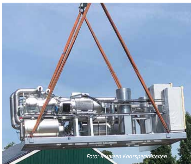
Plaatsing van de koude en warmtepomp bij Rouveen Kaasspecialiteiten
