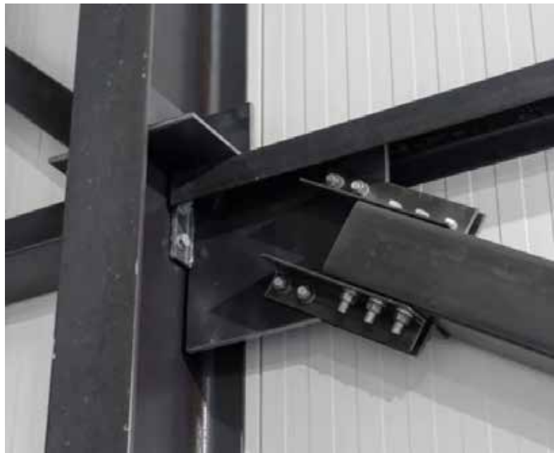
Een staalconstructie met bouten in plaats van met lasverbindingen
