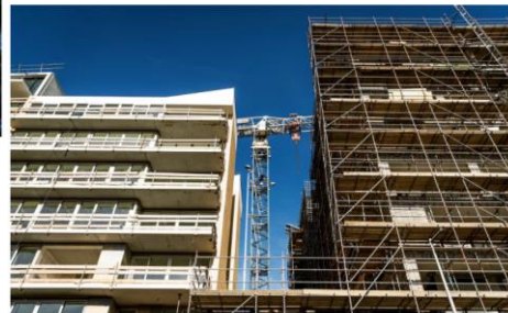
Een bouwproject in Buiksloterham, Amsterdam-Noord. Foto REMKO DE WAAL/ANP 08
