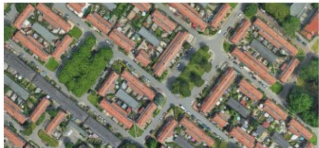
4. Tuindorp Lage grondgebonden rijwoningen die voor de oorlog zijn gebouwd met een zadeldak en eigen tuin. In de wijk is ook veel groen te vinden.
