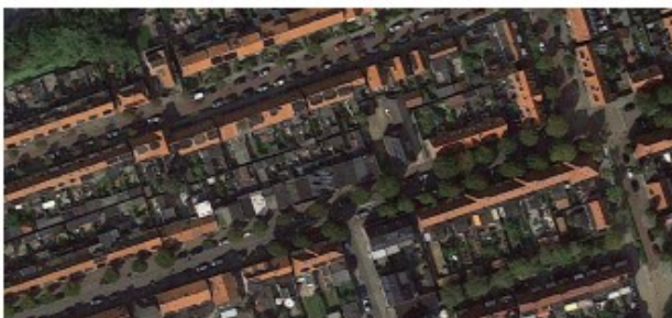
5. Volkswijk Lage kleine rijwoningen van voor de oorlog met een zadeldak. Dit kunnen ook benedenbovenwoningen zijn.
