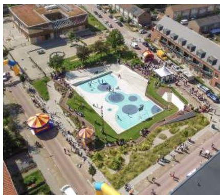
Waterplein Tiel - Bron: De Urbanisten
