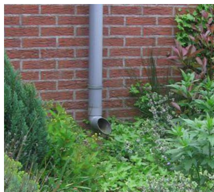
Regen wordt direct afgevoerd naar de geveltuin
