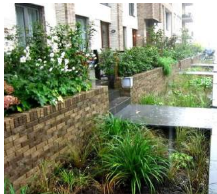
Bioswale langs bebouwing
