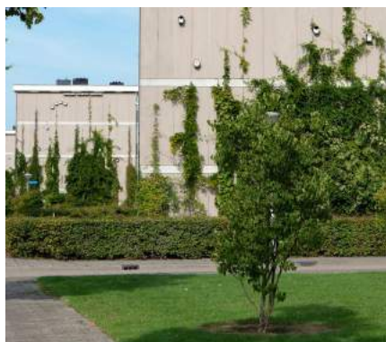
Verticale staalkabels voor windende gevelbegroeiing - Genderdal - Bron: Buro Lubbers
