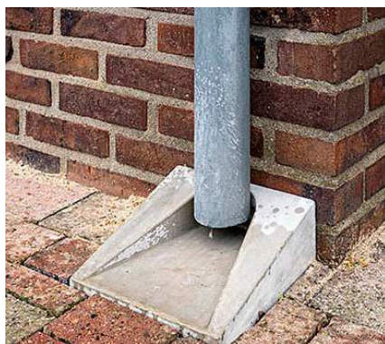
Afkoppel tegel bij een project in Maasbracht, referentie: GWW Totaal
