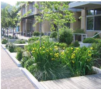
Bioswale als overgang tussen openbaar en privaat terrein
