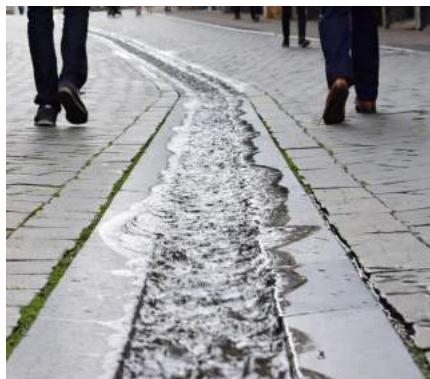
In deze referentie wordt permanent grondwater gepompt, dit type open goot kan echter ook droog worden uitgevoerd zodat het oppervlakkig afwateret - Stikke Hezelstraat, Nijmegen
