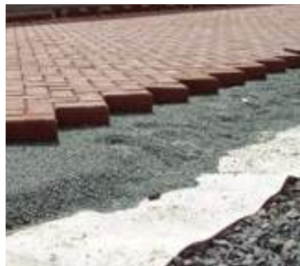
Opbouw Aquaflow; waterbergende wegfundering
