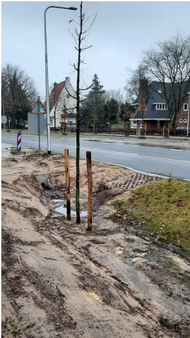
Figuur 8.2: niet te droog. En niet te nat? Wadi in aanleg (december 2021), waarin regenwater van t.b.v. klimaatadaptatie afgekoppelde weg wordt verzameld, met aangeplante eikenboom op diepste punt.
