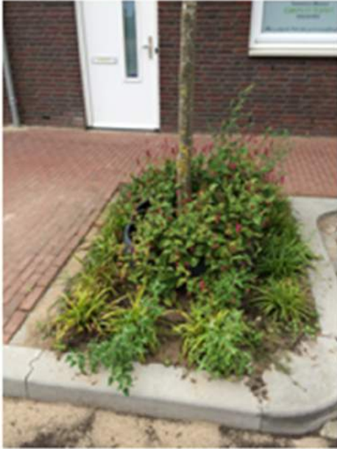
Figuur 4.3: Bevorderen opvang afstromend en doorvallend hemelwater
