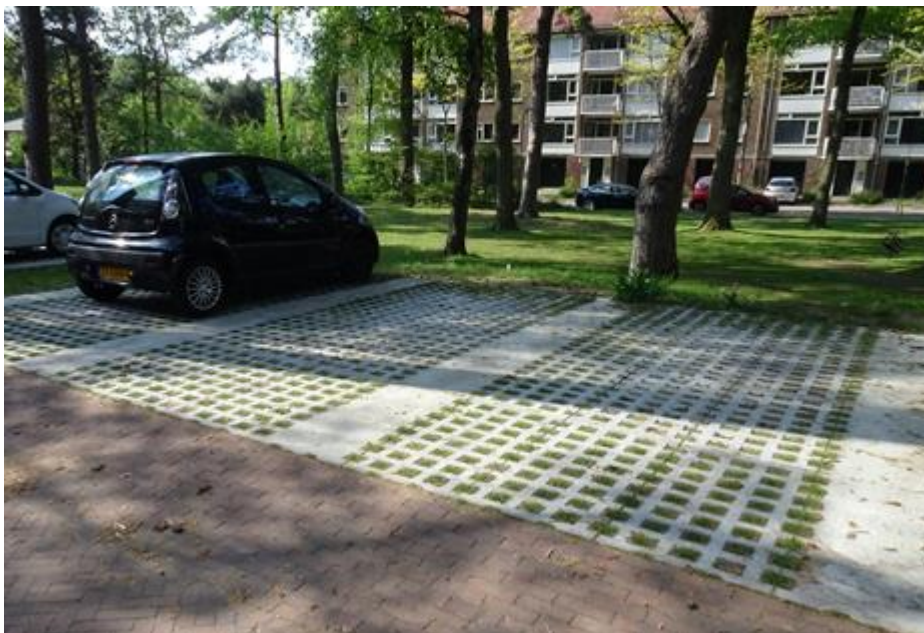
Figuur 7 Voorbeeld van grasbetonstenen op een parkeerplek (bron: Nanda Sluijsmans).
