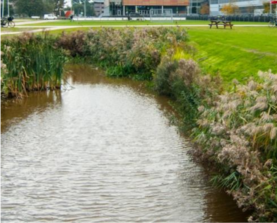
Figuur 17 Greppel geïntegreerd in een groenstrook naast een straat (bron: Merlijn Michon).
