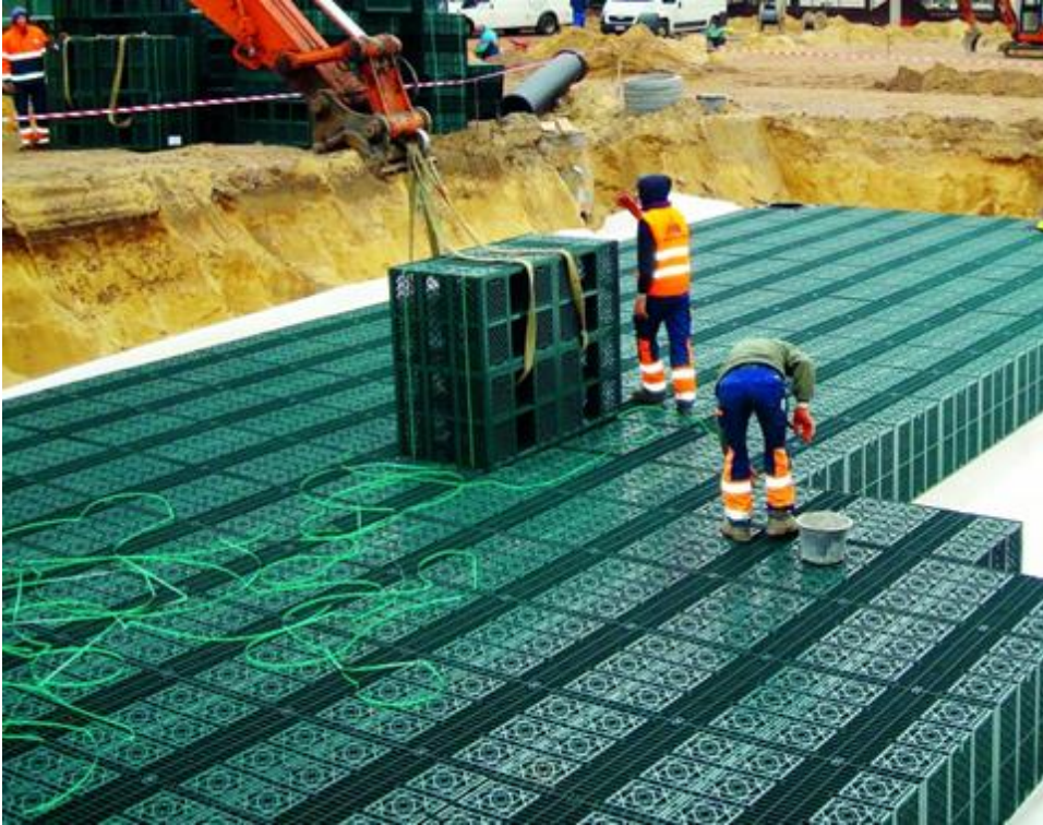
Figuur 25 Infiltratiekratten (bron: www.infra-infra.com ).
