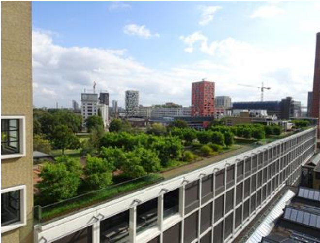
Figuur 2 Voorbeeld van een intensief groen dak (bron: Nanda Sluijsmans).
