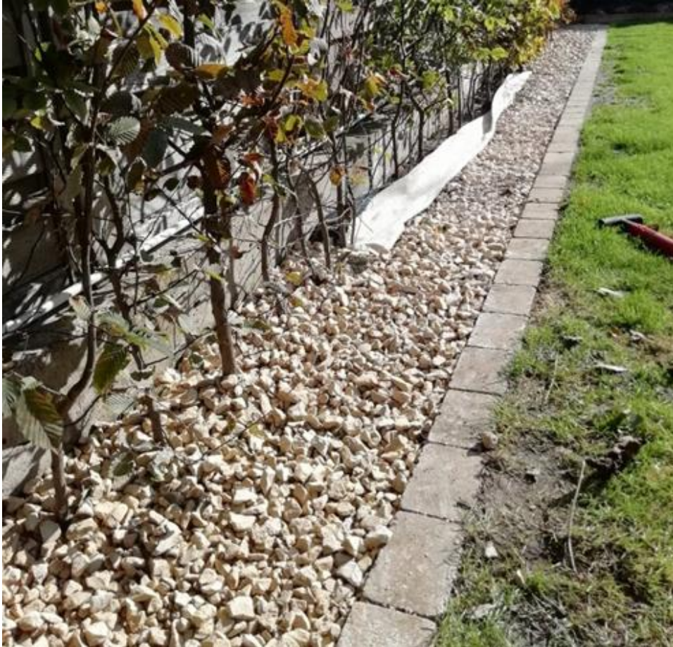
Figuur 18 Voorbeeld van een grindkoffer (bron: Blauw Groen Vlaanderen).
