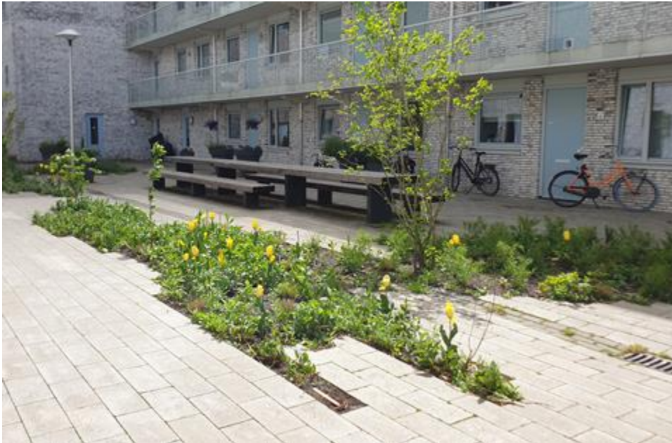
Figuur 6 Waterdoorlatende verharding (bron: Nanda Sluisjans).
