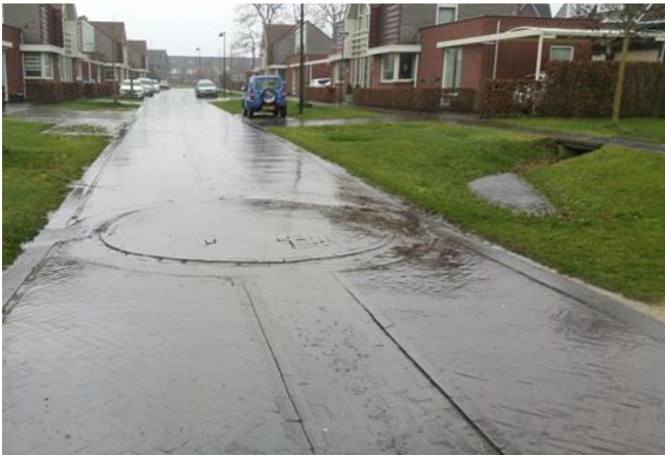
Figuur 8 Waterbergende wegfundering (bron: Nanda Sluijsmans).
