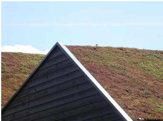
Figuur 1 Voorbeeld van een extensief groen dak (bron: Nanda Sluijsmans).
