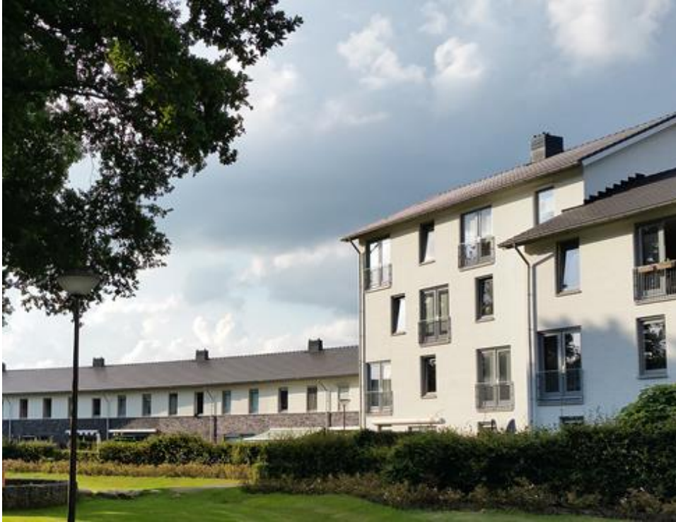
Figuur 32 Daken met een hoog albedo (bron: Nanda Sluijsmans).
