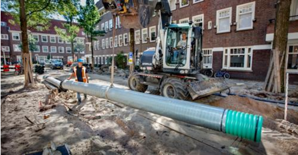
Figuur 19 Voorbeeld van een Drainage-Infiltratie-Transport (DIT) riool in de grond (bron: DigiDaan)
