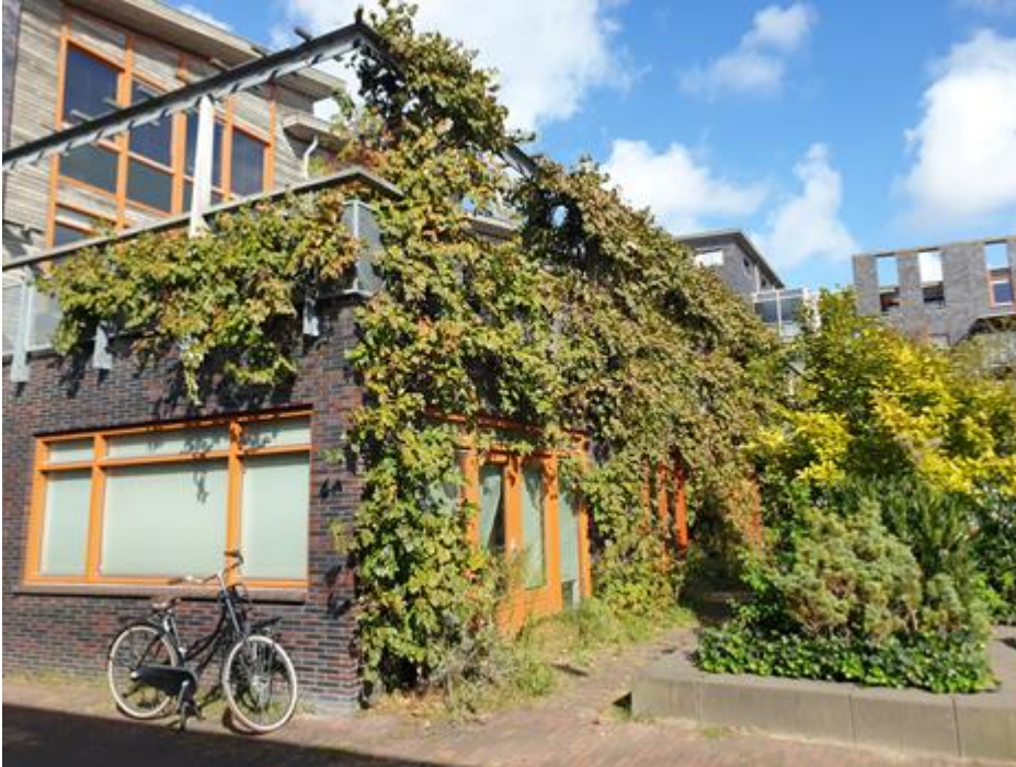
Figuur 29 Verticale vegetatie: living wall systeem (bron: Nanda Sluijsmans).
