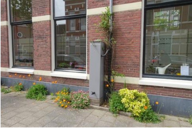
Figuur 4 Resultaat van het vervangen van tegels voor beplanting (bron: Nanda Sluijsmans).
