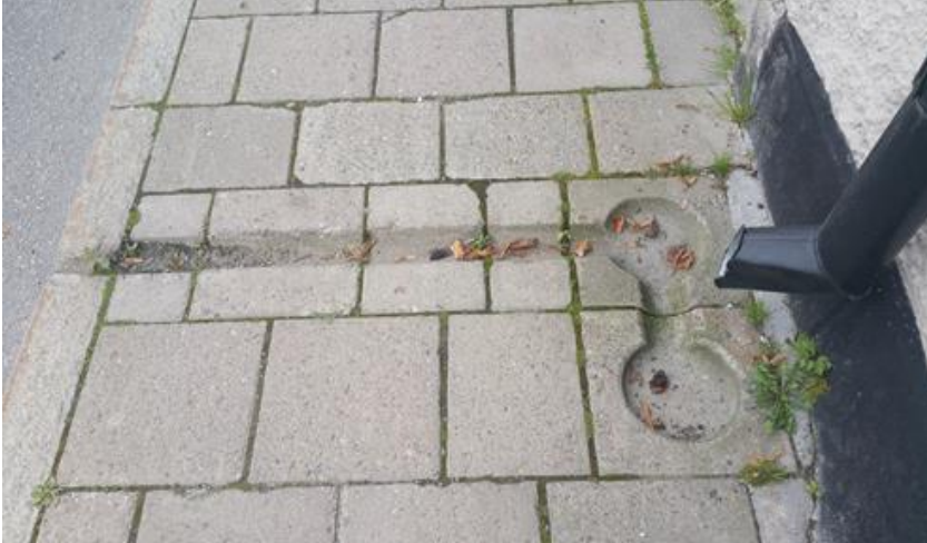
Figuur 14 Afgekoppelde regenpijp (bron: Nanda Sluijsmans).
