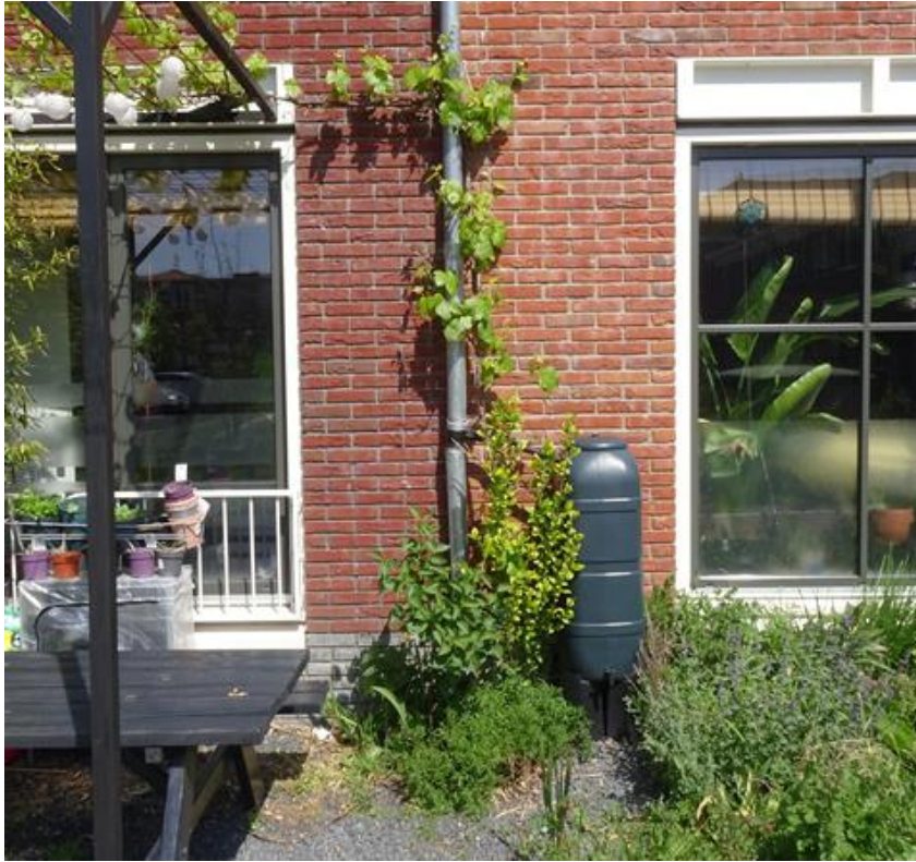
Figuur 12 Regenton (bron: Nanda Sluijsmans).
