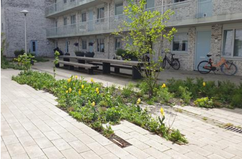
Figuur 6 Waterdoorlatende verharding (bron: Nanda Sluijsmans).
