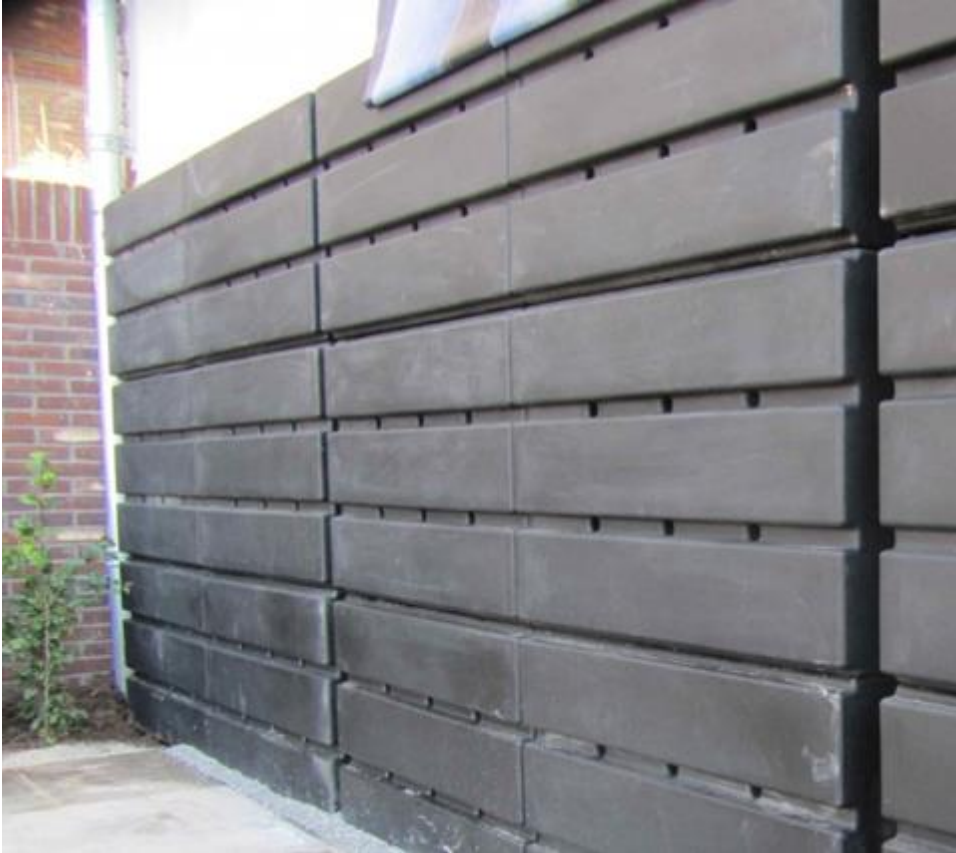
Figuur 13 Regenwaterschutting in de tuin (bron: Rainwinner)
