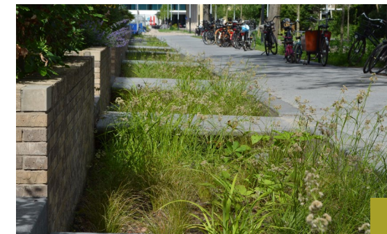
VERLAAGDE GROENSTROOK VOOR REGENWATERBERGING
