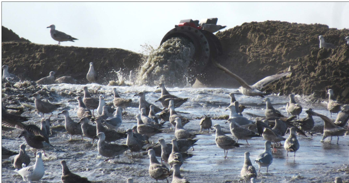
▲ Het opgezogen zand en daarmee ook het zeeleven wordt vermengd met zeewater opgespoten op het strand van Katwijk. Honderden meeuwen vormen geduchte concurrentie voor de conservator. (Trudy Langeveld)
