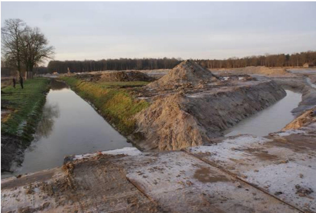
Klimaatbuffer in aanleg
