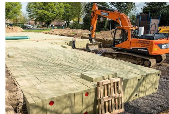
REALISATIE VAN 2500 M3 WATERBERGING IN LUPINE IN DE GEMEENTE MAASGOUW, GELEVERD DOOR LAPINUS
