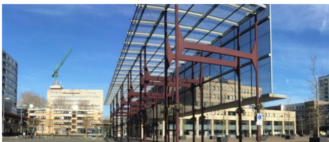
HET KONINGSPLEIN VANUIT ZUIDELIJKE HOEK
