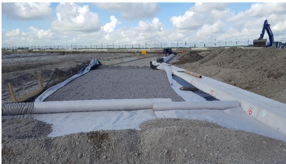
Afb. 4: Aanleg AquaBASE onder de shoulder
