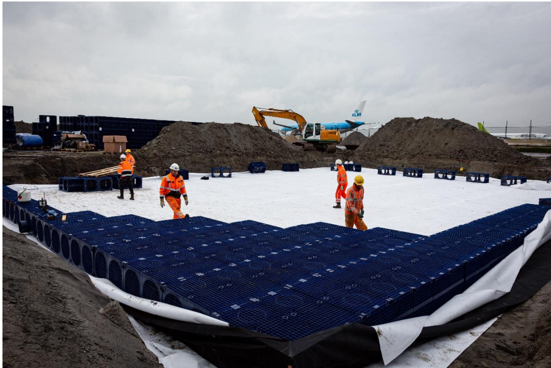
Afb. 5: Aanleg Wavin krattenveld
