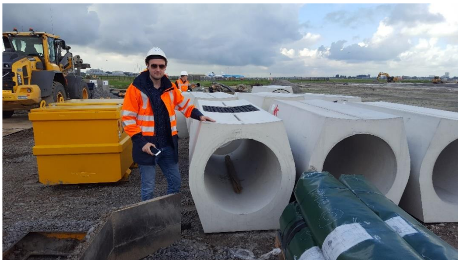
Afb. 3: Vergrote verholen goot \varnothing 800 mm.
