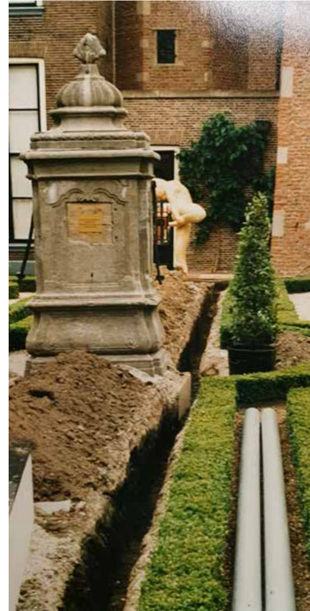
Afb. 71 Aanleg riolering 1987 (SMZ).
