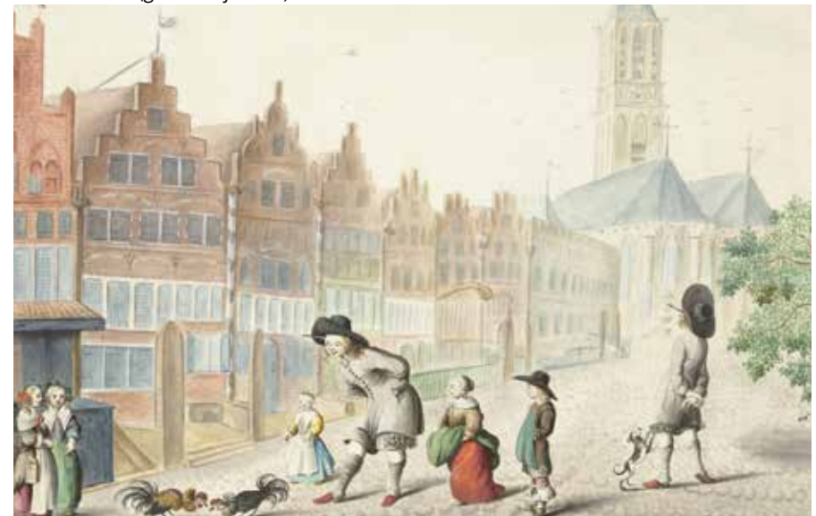
Afb. 30 Op deze prent van G. ter Borch uit 1655 van de Sassenstraat in Zwolle zijn aan de gevels van de panden fraai vormgegeven balken of hemelwaterafvoeren met daarop eenvoudige spuwers te herkennen (Rijksstudio).
