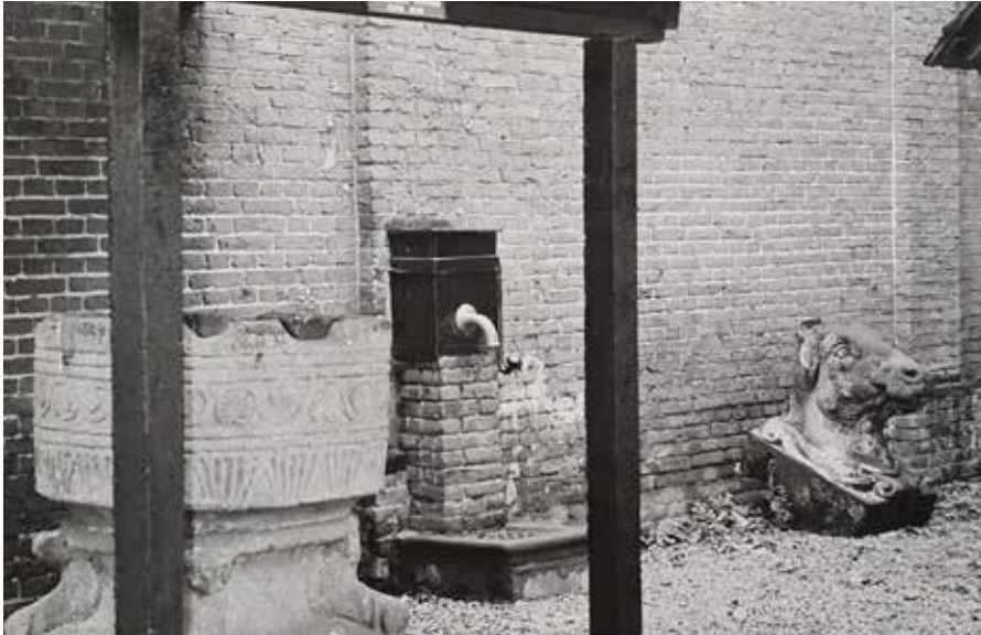
Afb. 57 Eenvoudige waterpomp tegen de erfafscheidingsmuur aan (Voorstraat), mogelijk gebruikt voor drinkwater voor de paarden en bewatering van de tuin ('60, SMZ).
