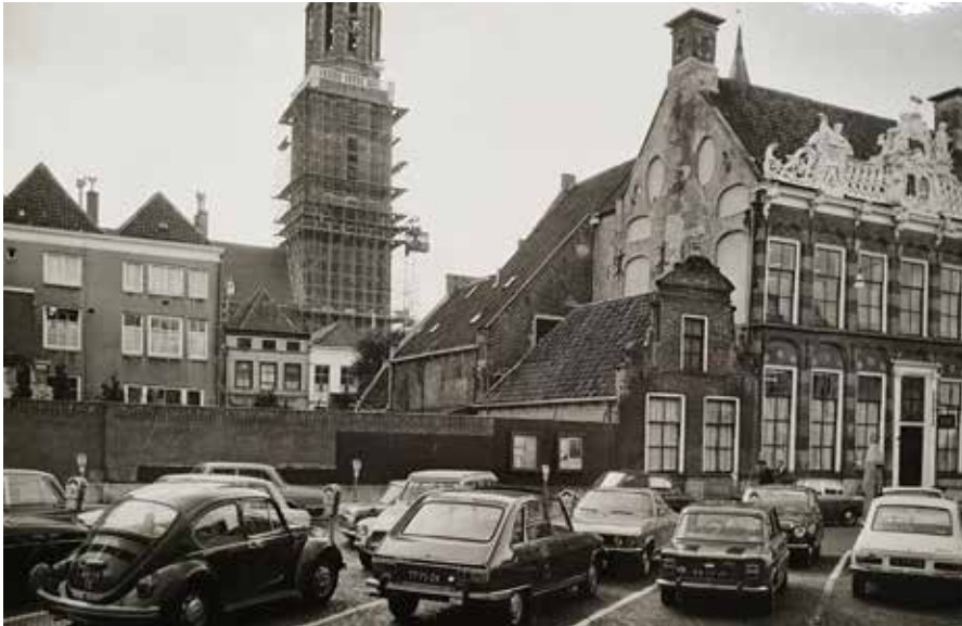
Afb. 47 Wat overbleef na de sloop van het telegraafkantoor en het koetshuis was een lege vlakte, die lange tijd oningevuld bleef. Foto eind '60/begin '70 (Archief SMZ).
