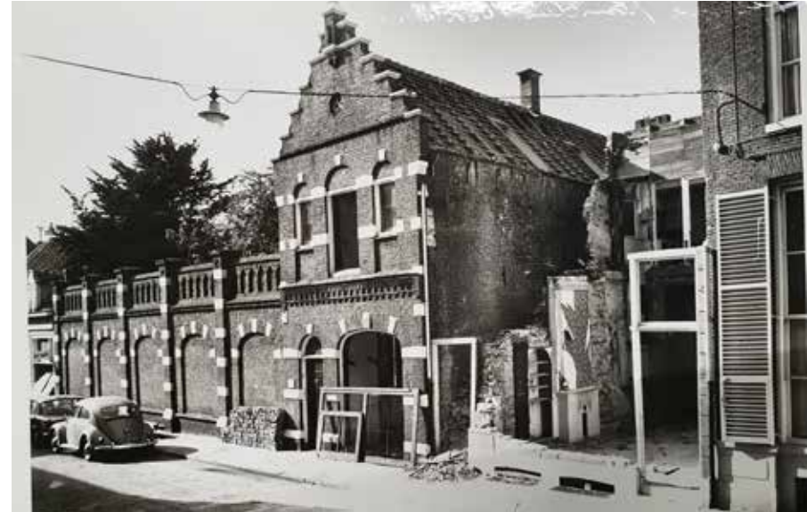
Afb. 44 Sloop van het voormalige koetshuis aan de Voorstraat en telegraafkantoor. Foto juli 1965 (Archief SMZ).
