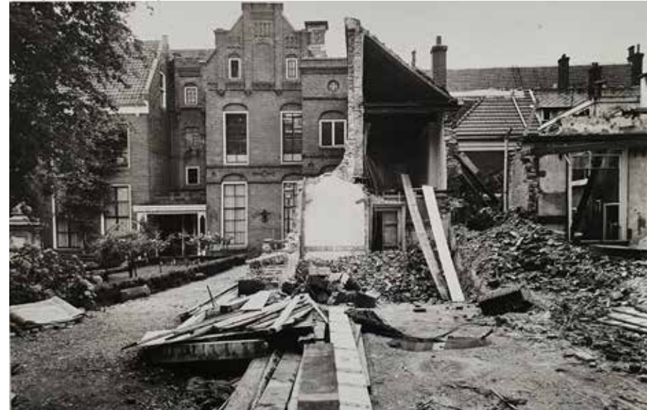
Afb. 46 Sloop van het voormalige koetshuis aan de Voorstraat en Telegraafkantoor. Foto juli 1965 (Archief SMZ).
