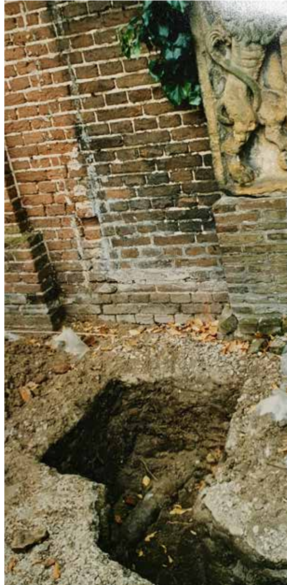
Afb. 70 Aanleg riolering 1987 (SMZ).
