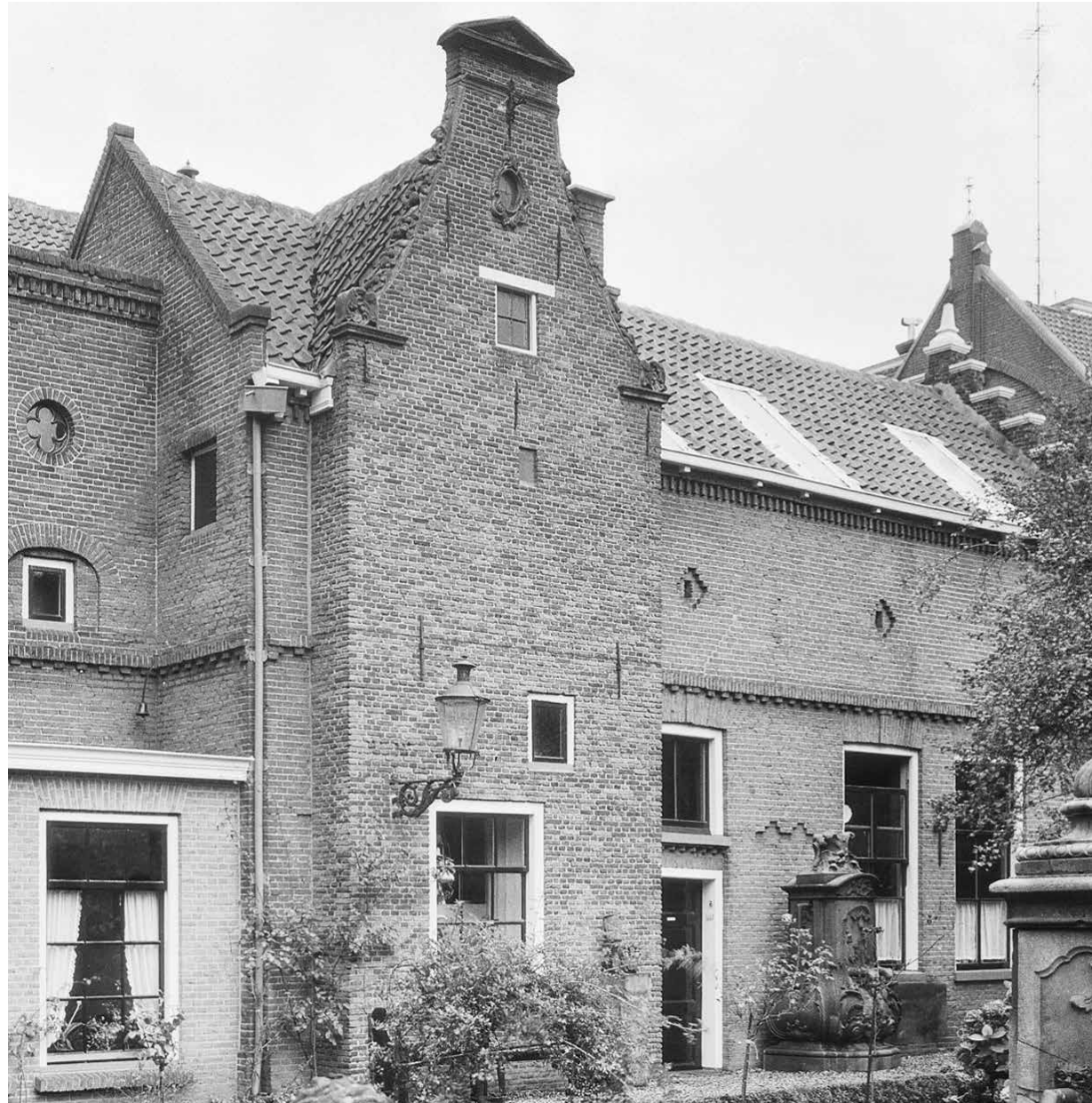
Afb. 55 Achttiende eeuwse waterpomp tegen het oude koetshuis. Deze pomp is verdwenen (foto 1960, RCE_059903).
