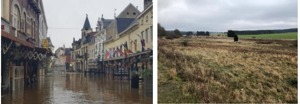
Figuur 2: Overstromingen in Valkenburg in juli 2021 (links). Herstel van bovenstroomse sponsgebieden (rechts) is een maatregel waarmee overstromingsrisico's in Valkenburg en andere steden in hoog Nederland verminderd kunnen worden. Voor deze opgave lijkt de meest effectieve oplossing dus niet in het peri-urbane gebied te liggen, maar (ver) daarbuiten.
