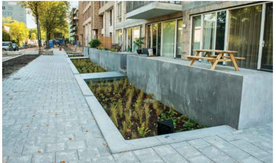
The green urban infiltration strip at Zuidelijke Wandelweg.
