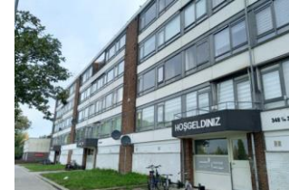
Standaard voor woningsisolatie
