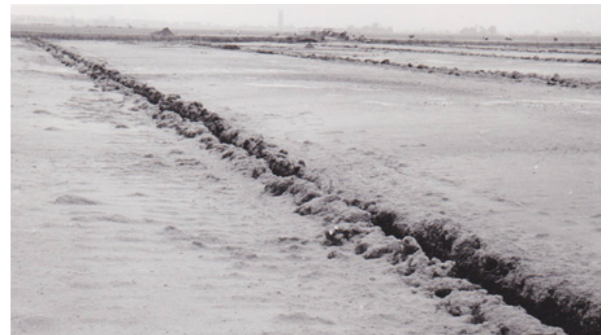
Afb. 3.71 Het tegengaan van droogte lijkt tegenwoordig vaak een grotere opgave dan het voorkomen van wateroverlast, maar in de vorige eeuw werden nog tal van ontwateringswerken uitgevoerd. Kunstmest had de noodzaak van winterbevoeiing overbodig gemaakt. Op deze foto, rond 1957 gemaakt te Hasselt, is te zien hoe machinaal sleuven werden gegraven ten behoeve van ontwatering. Dergelijke werkzaamheden konden ook los staan van ruilverkavelingen.
