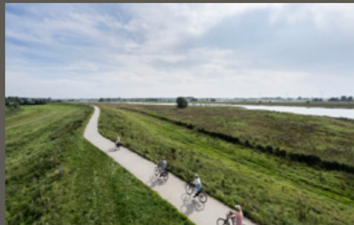
Afb. 4.4 De IJsseldijk langs polder het Mastenbroek beschermt de polder tegen hoog water
