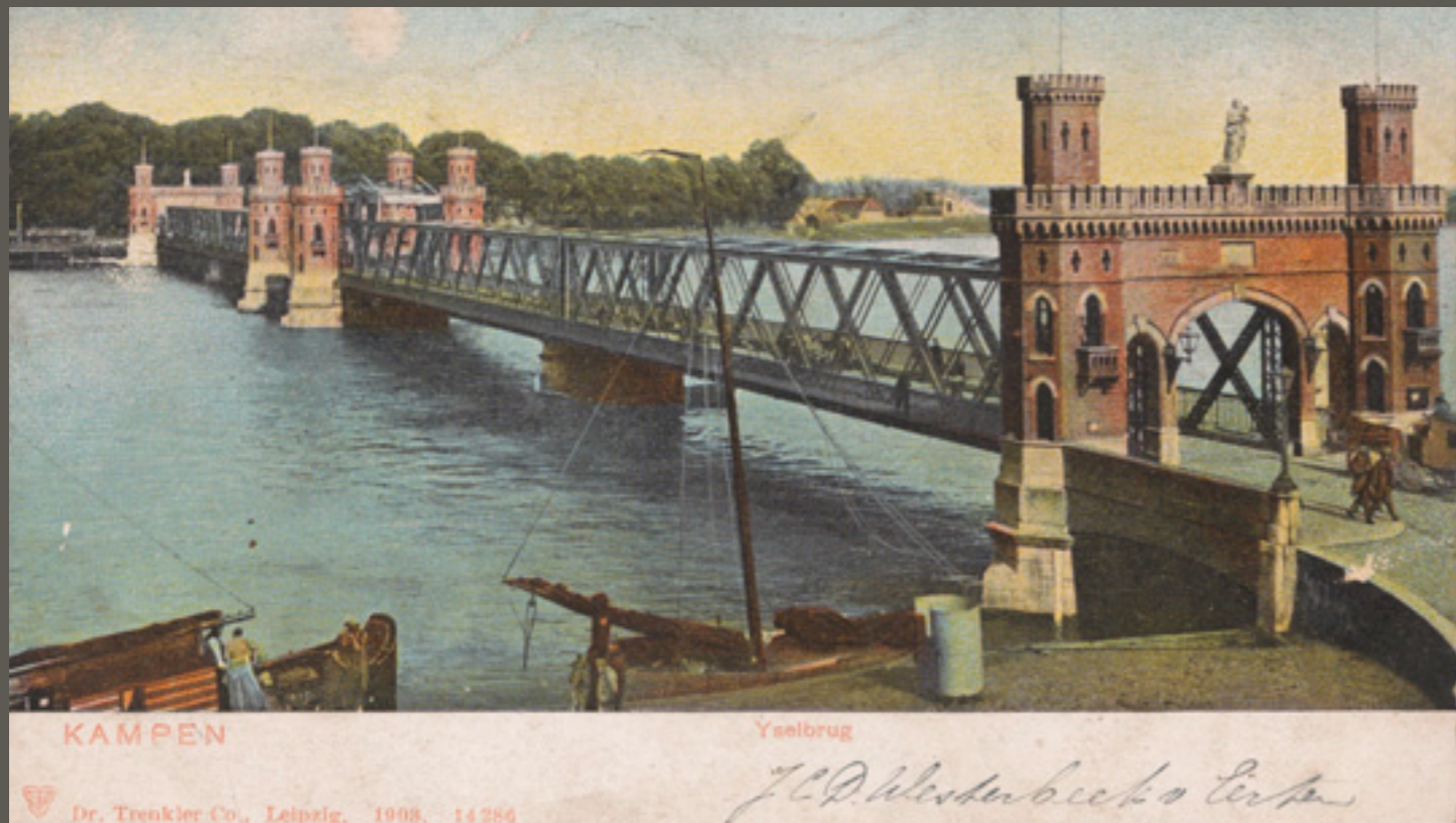
Afb. 3.23 IJsselbrug bij Kampen, 1908.
