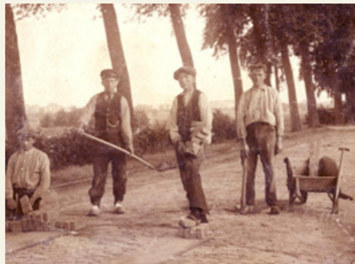
Afb. 3.36 De aanleg van de Zuiderzeestraatweg.
