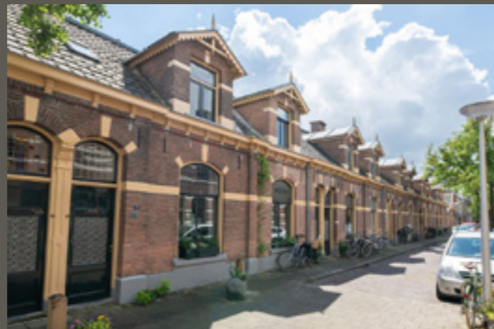
Afb. 3.20 Sociale arbeiderswoningen in de Eigenhaardstraat, Zwolle.
