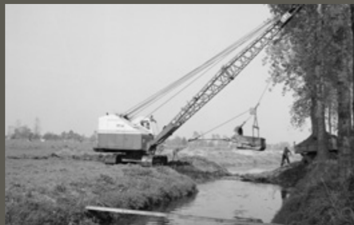
Afb. 7.17 Werkzaamheden aan de Soestwetering in 1965 t.b.v. versnelde afvoer van water.
