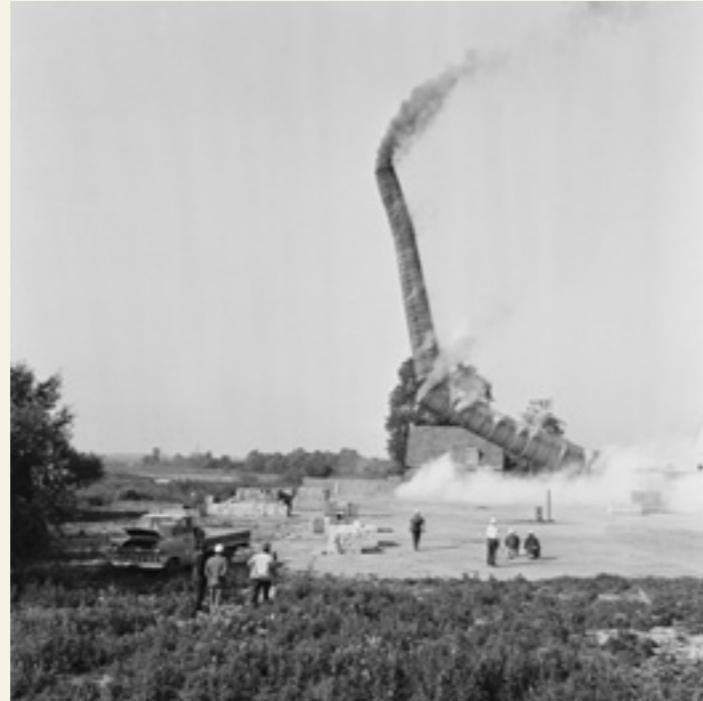
Afb. 3.42 De schoorsteen van steenfabriek Windesheim wordt opgeblazen
