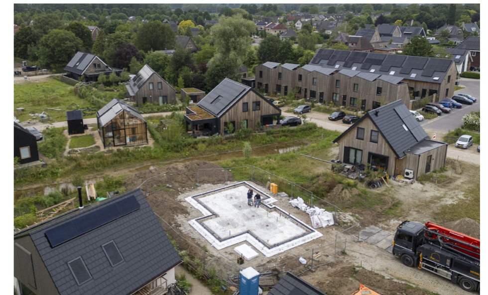
Fig. 13 Kruipruimteloos bouwen, links Schermerhorn, rechts Olst (bron: Hectar Funderingstechniek)
