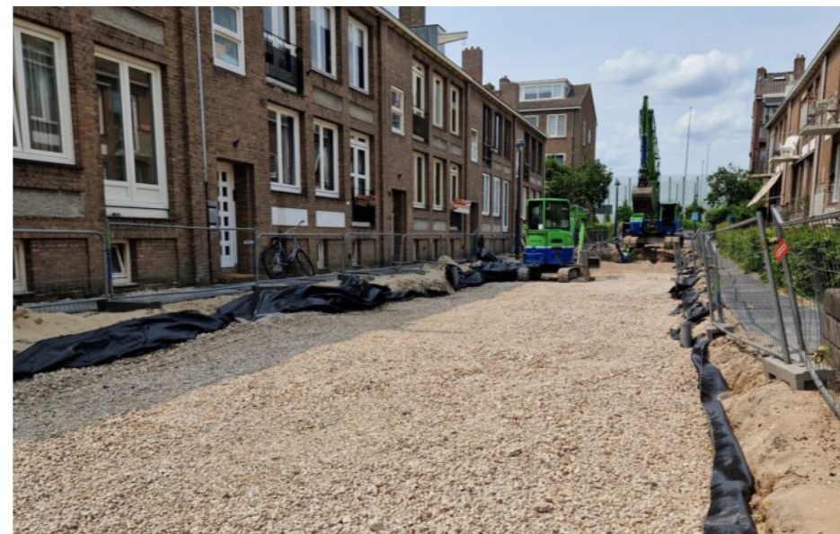
Fig. 30 Licht ophoogmateriaal, Diemen (bron: H&B Grondstoffen)
