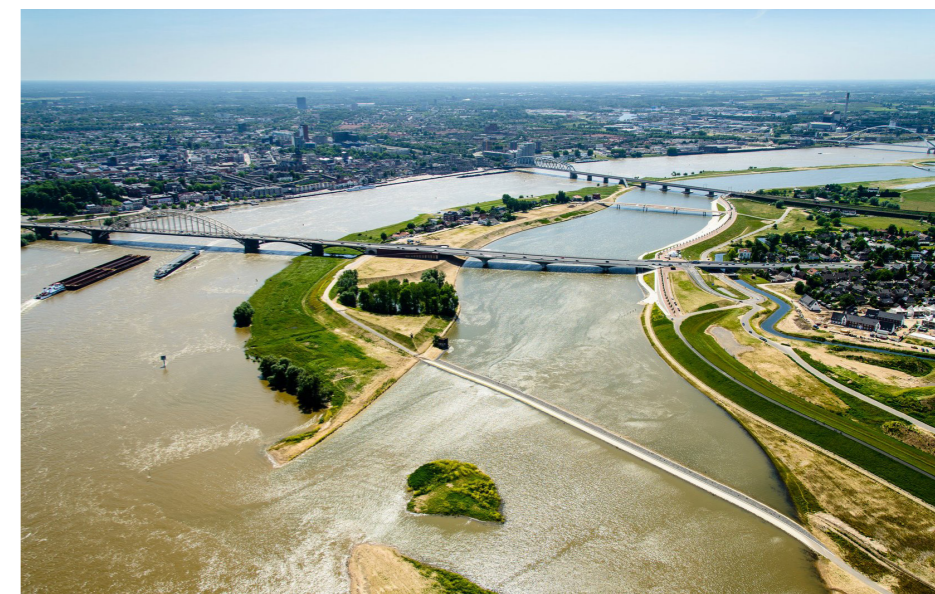
Fig. 21 Infrastructuur Ruimte vd Waal, Nijmegen (bron: Siebe Swart)
